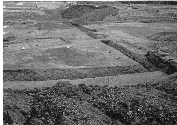
SD03全景（西から）
