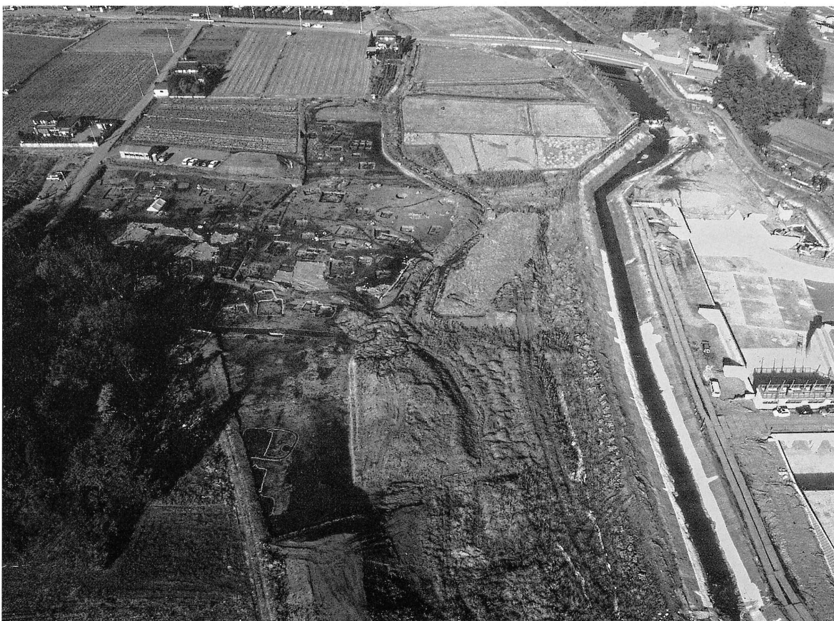
遺跡遠景（南東上空から）
