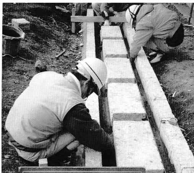
64 外構工事 雨落
