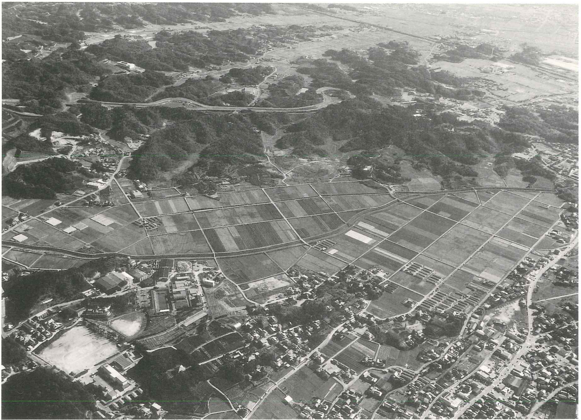
遺跡遠景（北西から）
