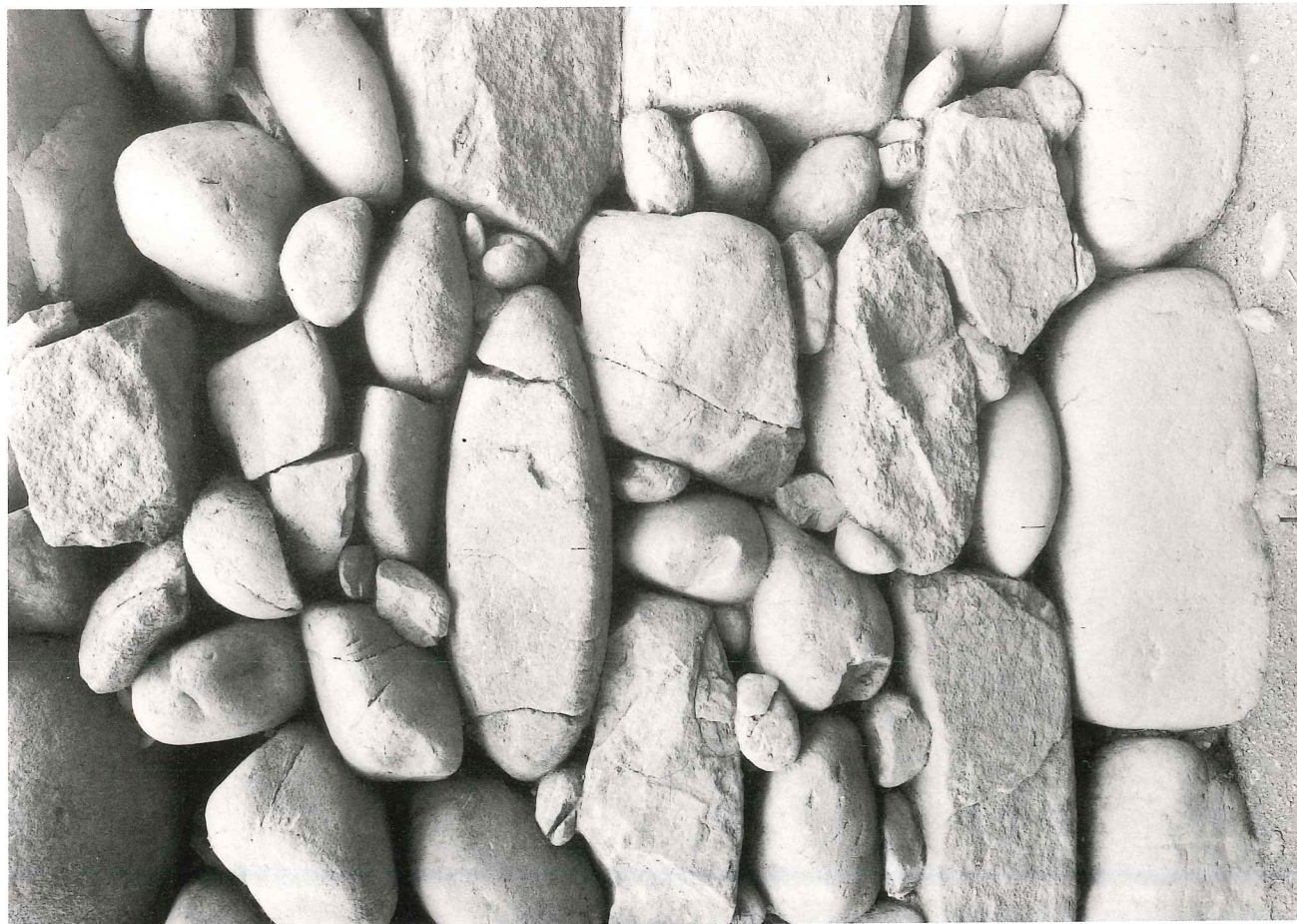
(2) 側壁の石組み状況
