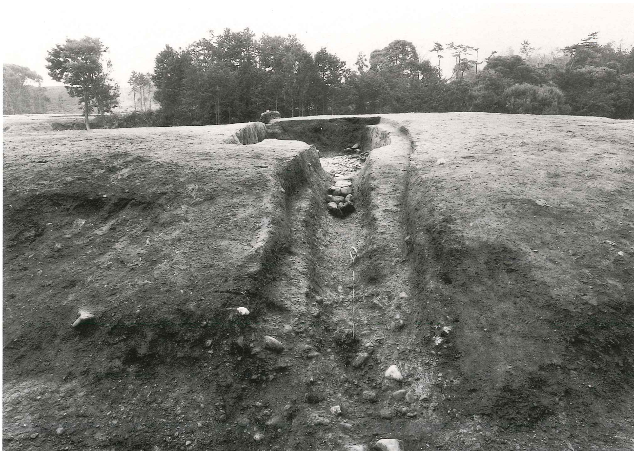
(2) 団子塚10号墳排水溝（北より）
