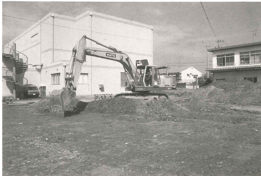
2. バックホーによる表土発掘状況
