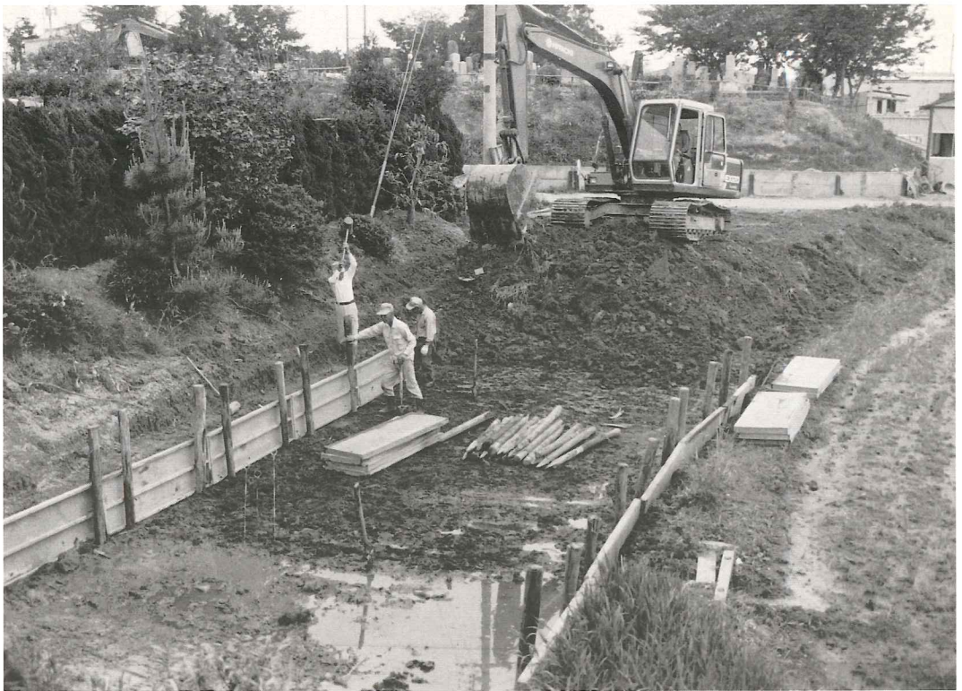
(A) 埋土・表土除去作業
