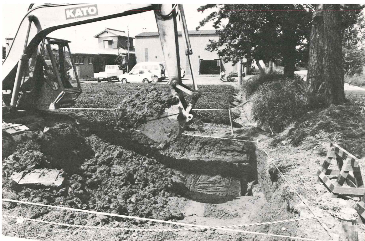
(A) 重機による盛土の除去作業
