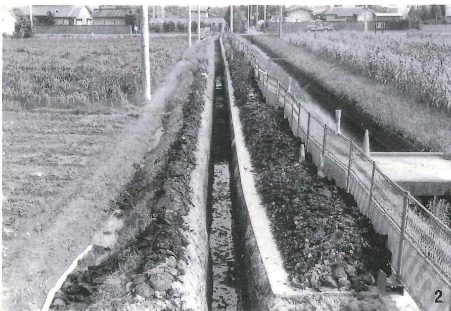
2.1 トレンチ北半有 機質土層検出状況 (北より)
