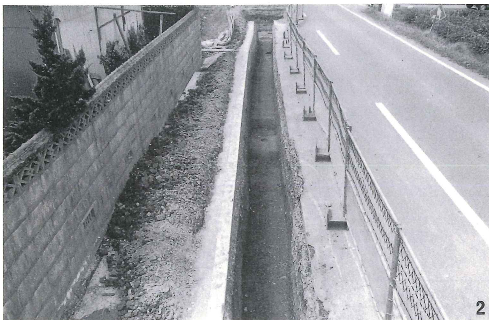
2.3 トレンチ全景 (東より)
