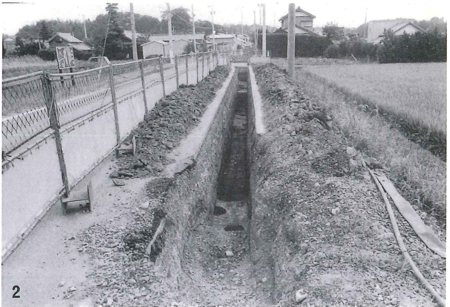
2. 4 トレンチ全景 (西より)
