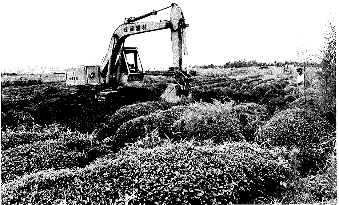
口区表土掘削状況
