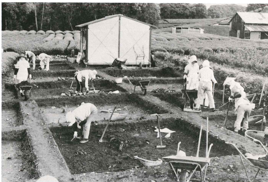
(2) セクションベルト を残して掘り下げ
