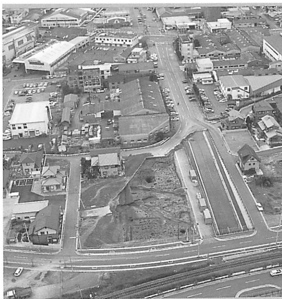
第26図 調査区全景（東方向から）
