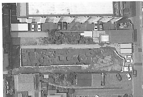
第125図 調査区全景空中写真
