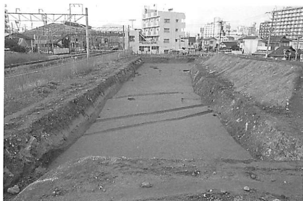
第136図 調査区全景（東方向から）
