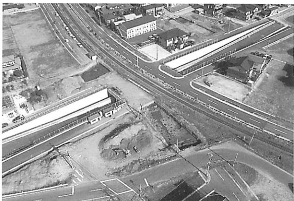
第27図 調査区全景（南西方向から）
