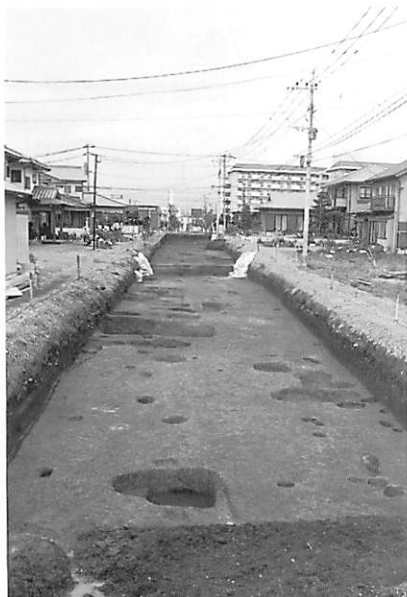
第31図 調査区全景（東方向から）
