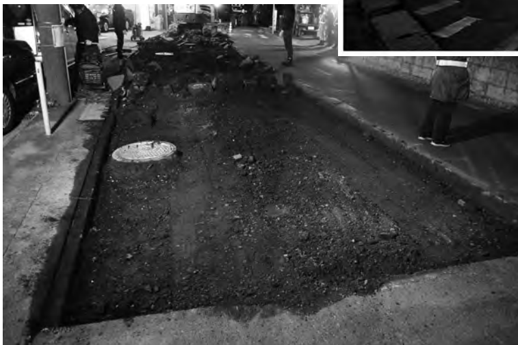
写真6 夜間工事立会い路盤材掘削状況
