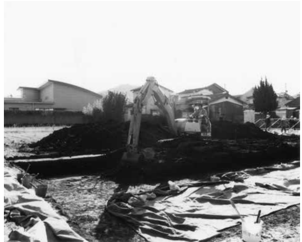
第3図 表土剥ぎ風景（北西から）
