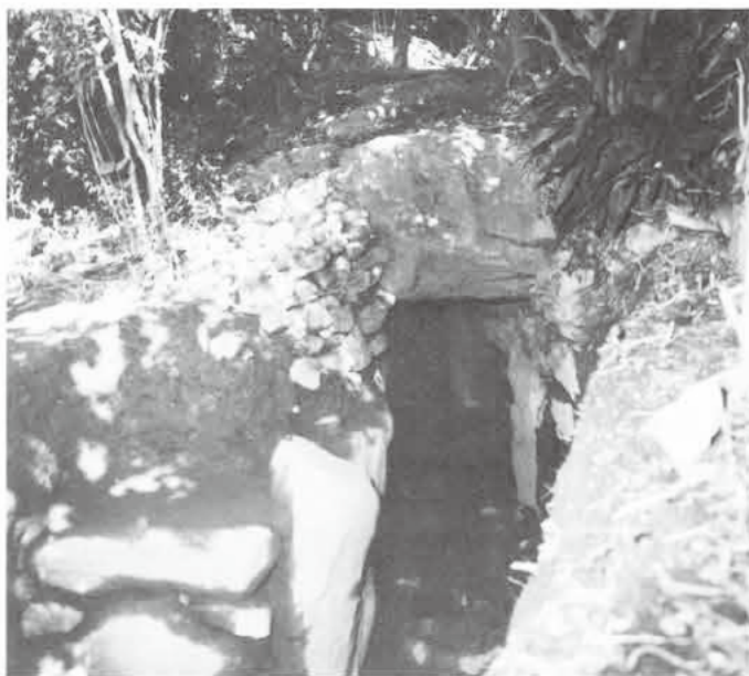
石室入口全景（南西より）
