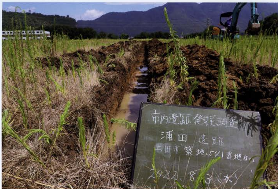
トレンチ掘削（南から）
