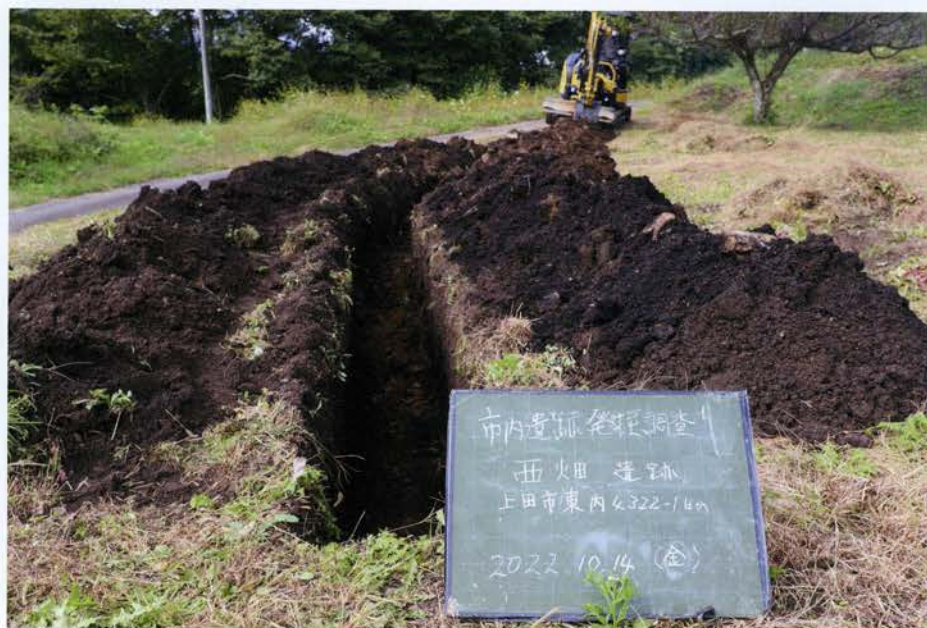
完掘状況 (西から)
