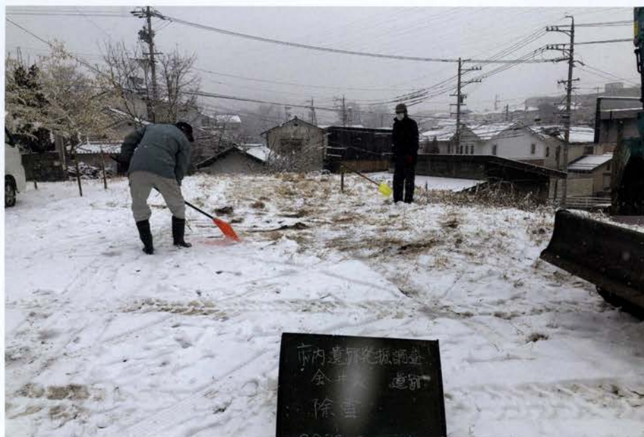
除雪作業（西から）
