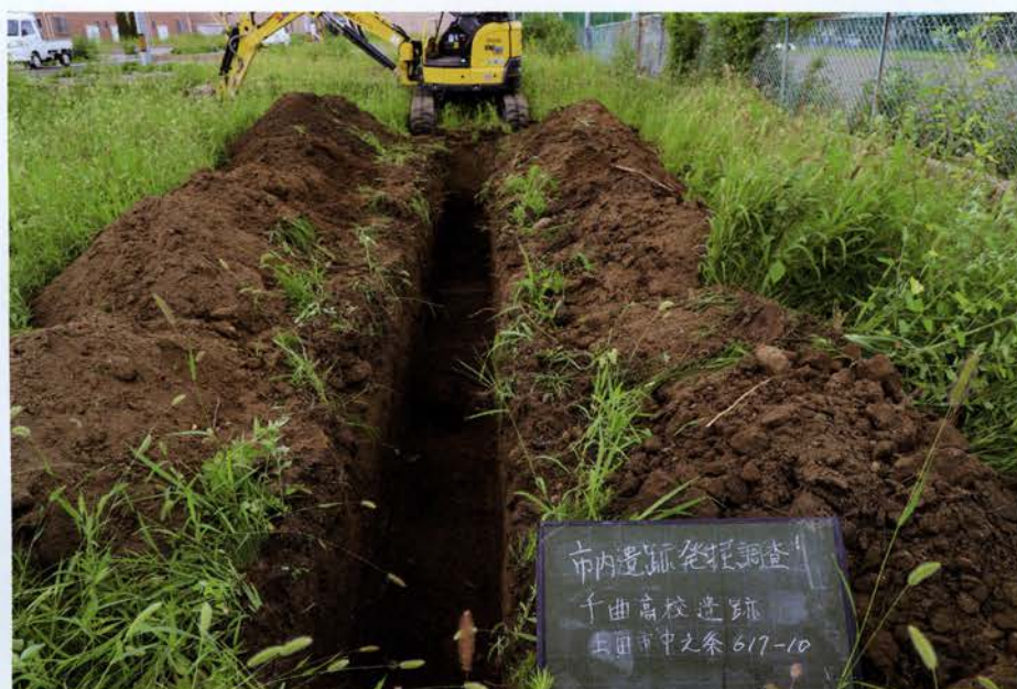
トレンチ掘削（西から）
