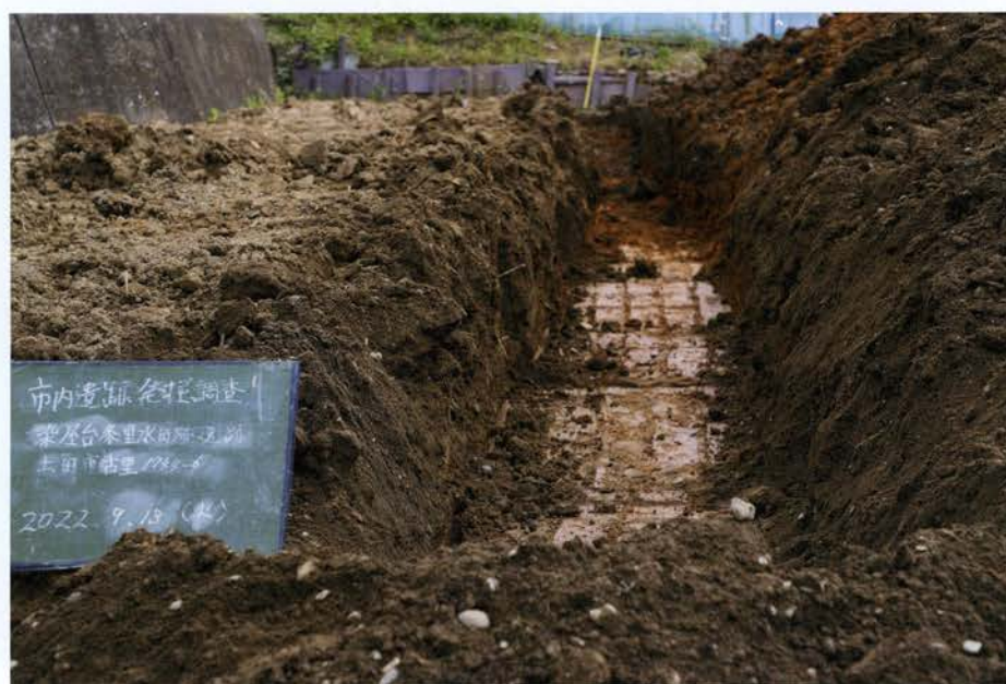
トレンチ全体（東から）
