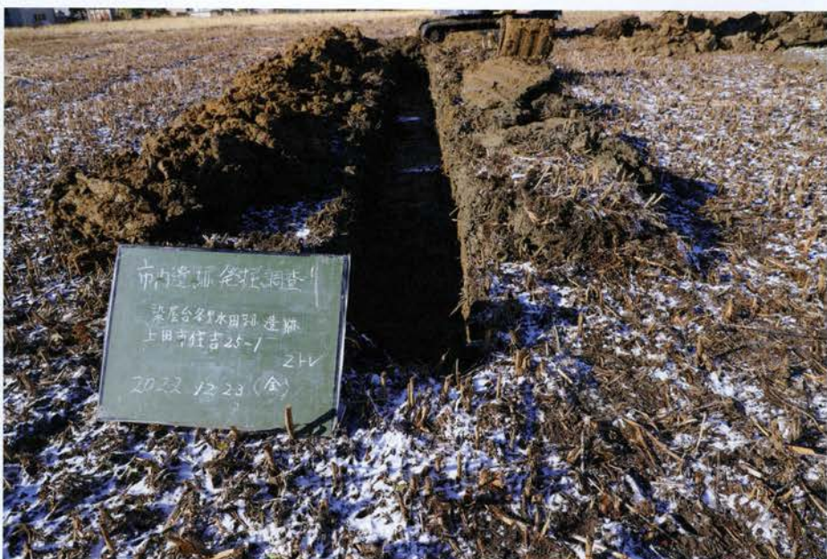
Tr-02 掘削状況（南から）
