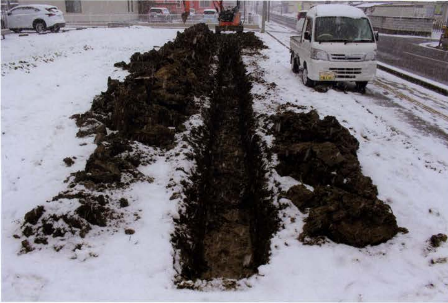
トレンチ掘削（北から）
