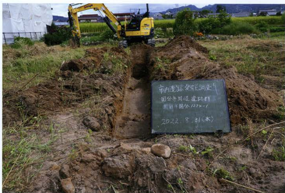
完掘状況 (南から)
