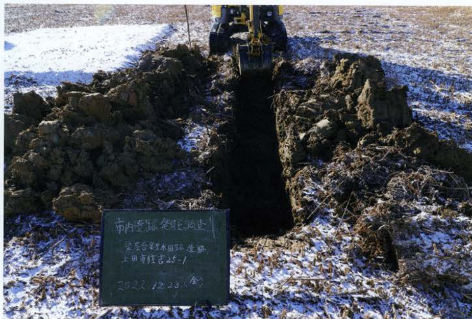
トレンチ掘削（南から）
