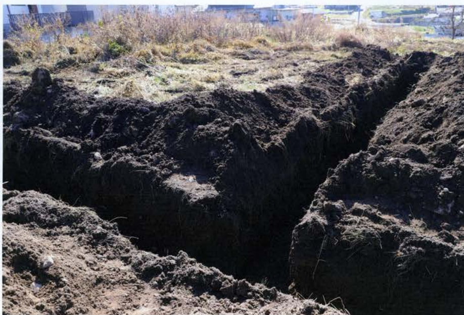
トレンチ掘削状況
