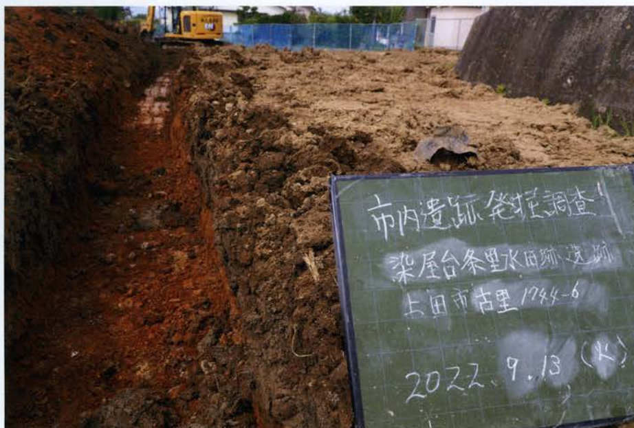
トレンチ掘削（西から）
