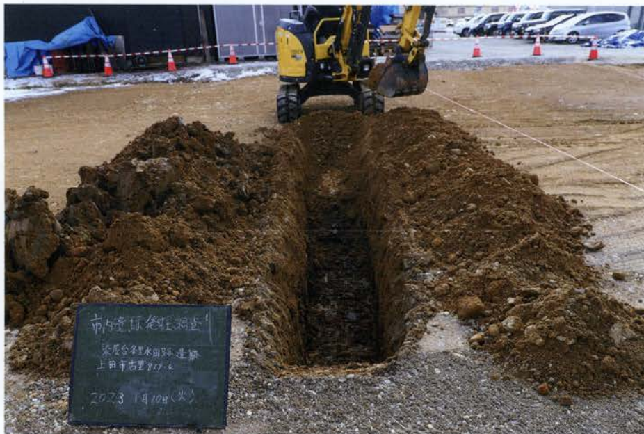
トレンチ掘削状況（北から）
