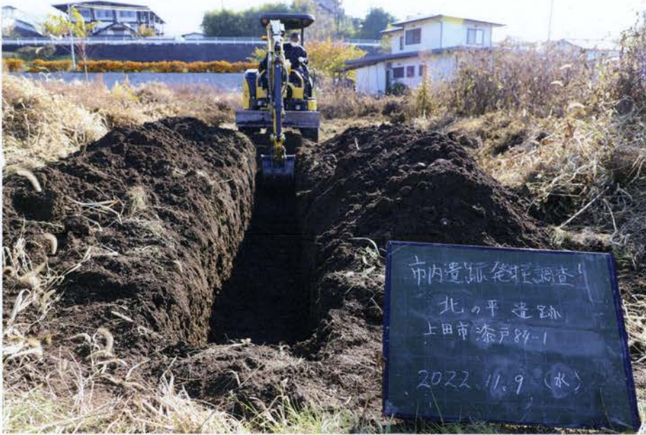
Tr-01 掘削（北から）
