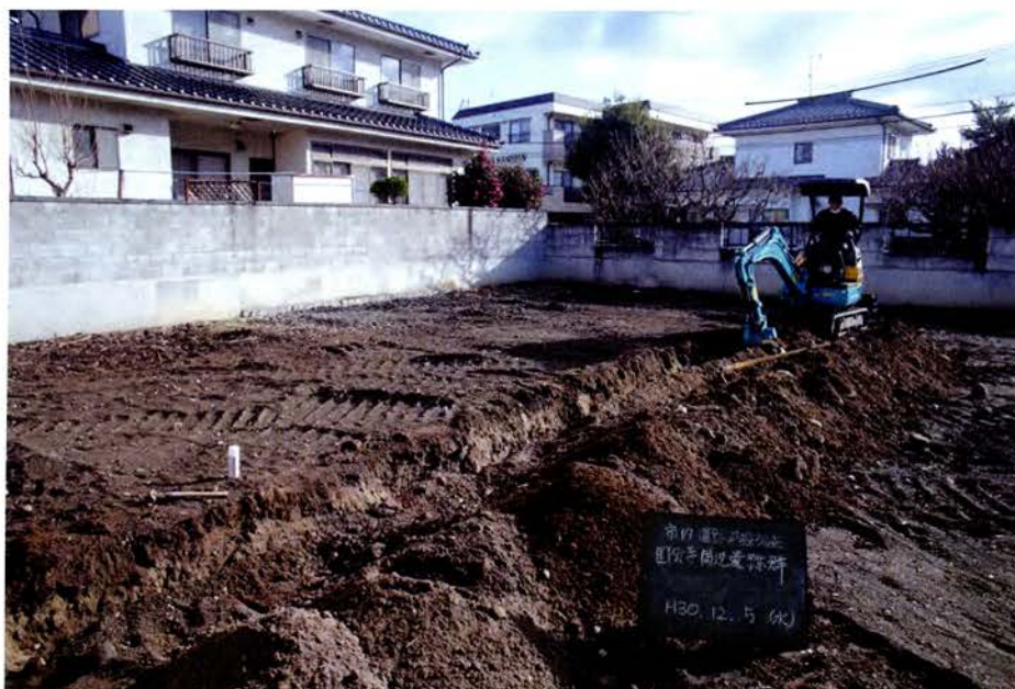
トレンチ (南西から)
