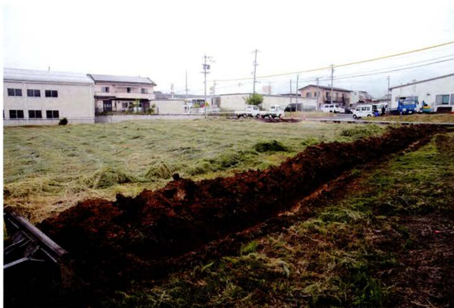
トレンチ掘削（南西から）
