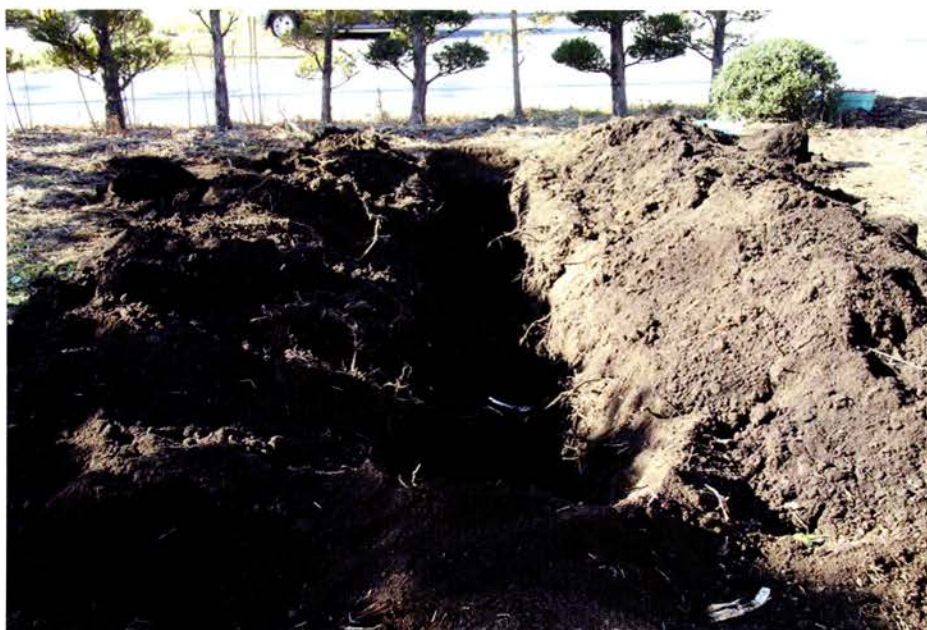
トレンチ掘削（東から）
