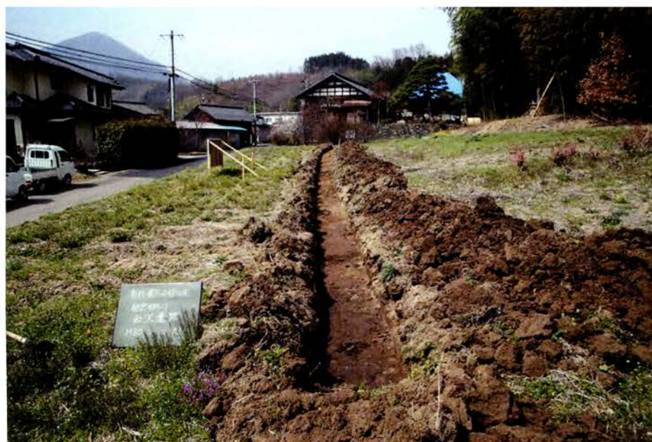
トレンチ掘削（東から）
