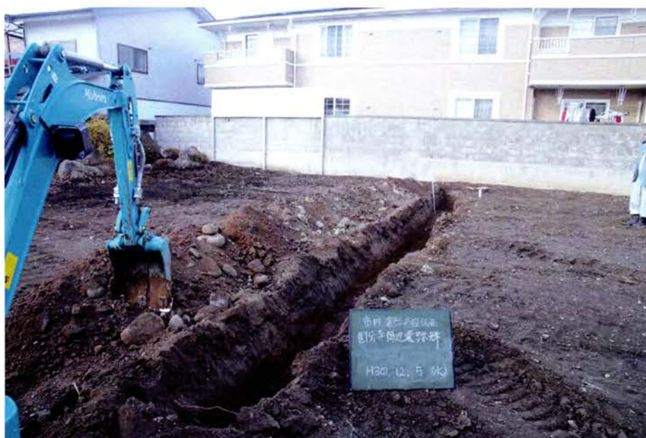
トレンチ (北東から)
