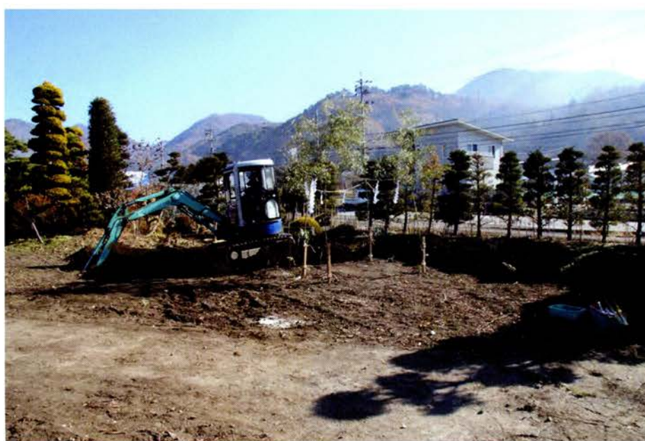
トレンチセクション（南から）
