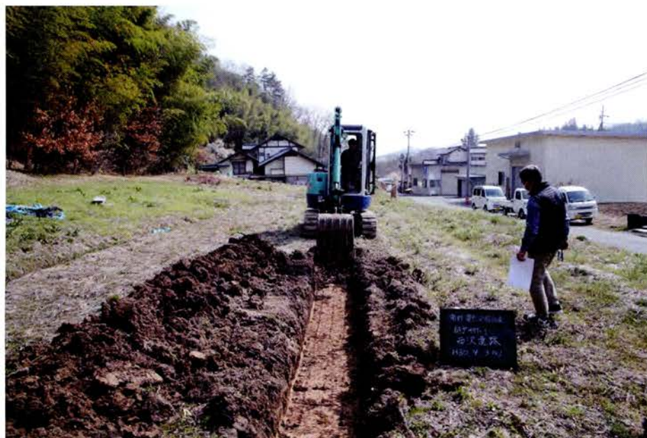
トレンチ掘削（西から）
