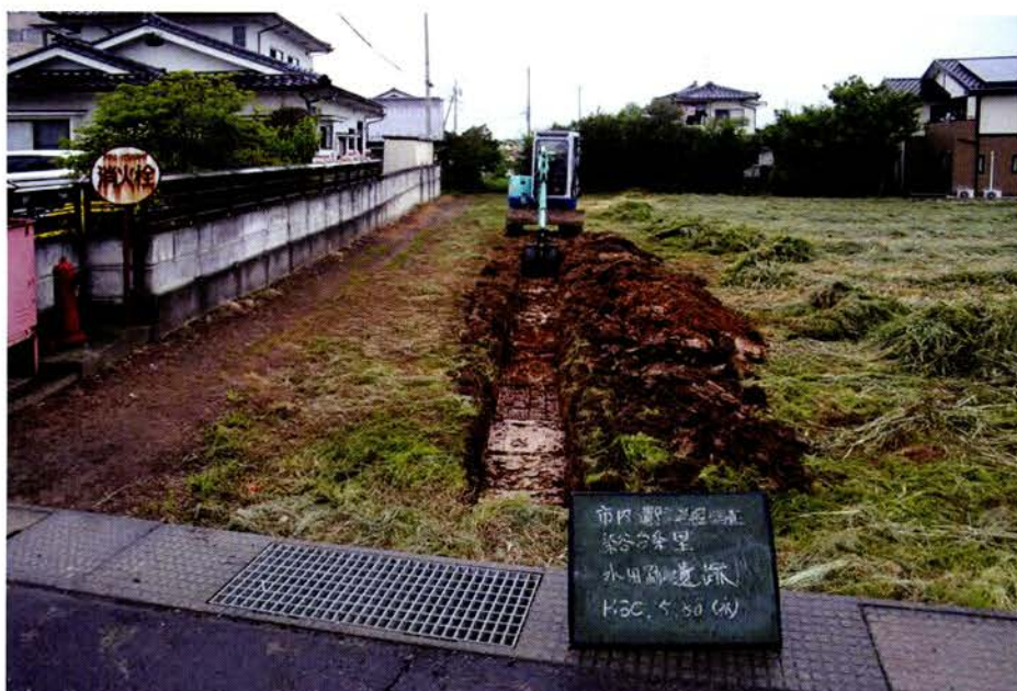
トレンチ掘削（東から）
