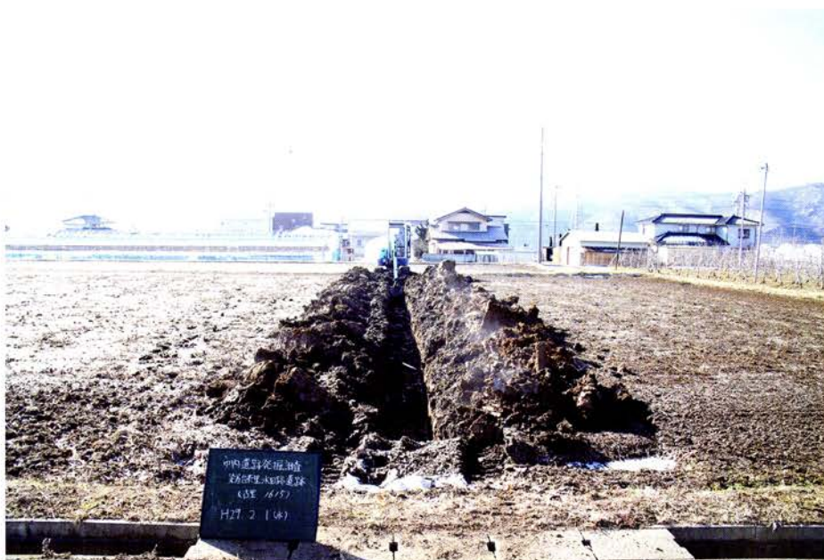
Tr-01 掘削状況（北から）
