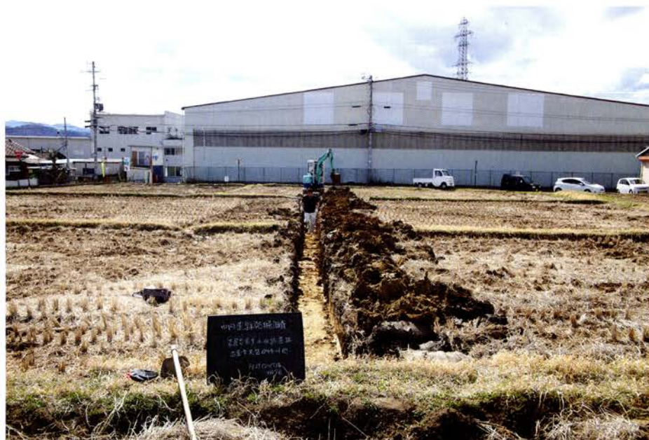
トレンチ掘削（東から）
