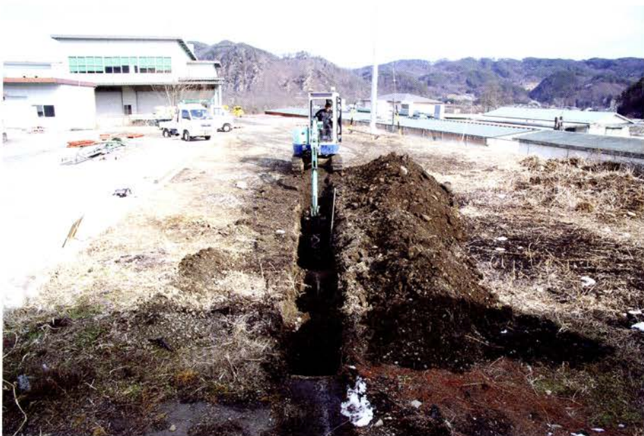
トレンチ掘削（西から）
