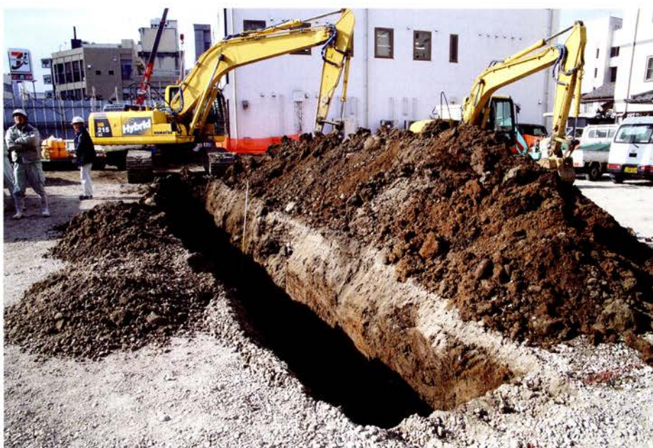
トレンチ掘削（北東から）
