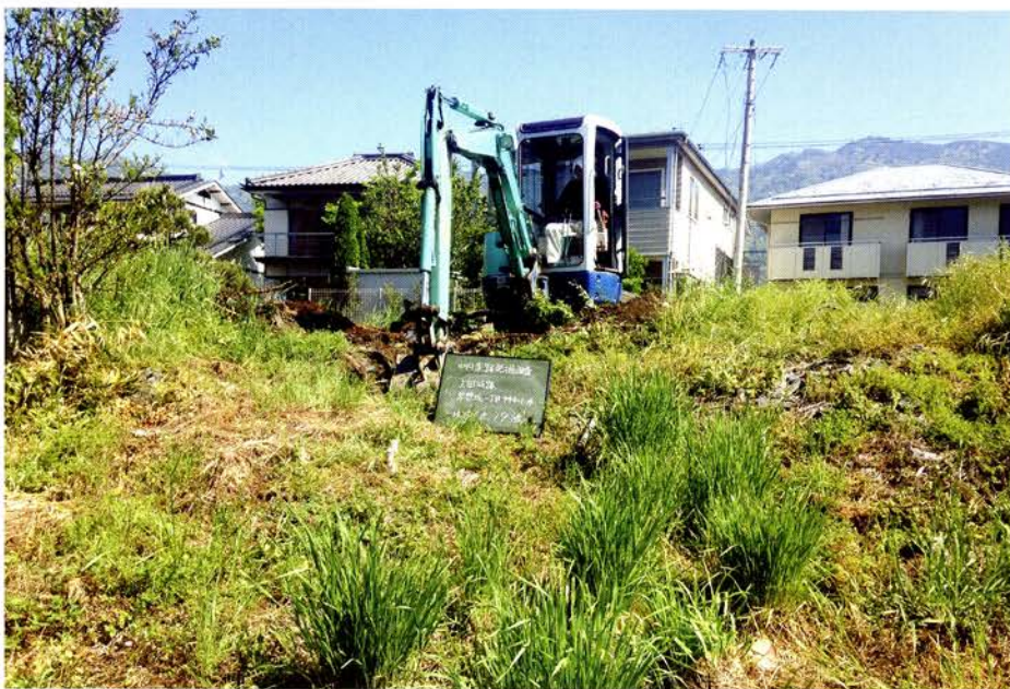
トレンチ掘削（南から）
