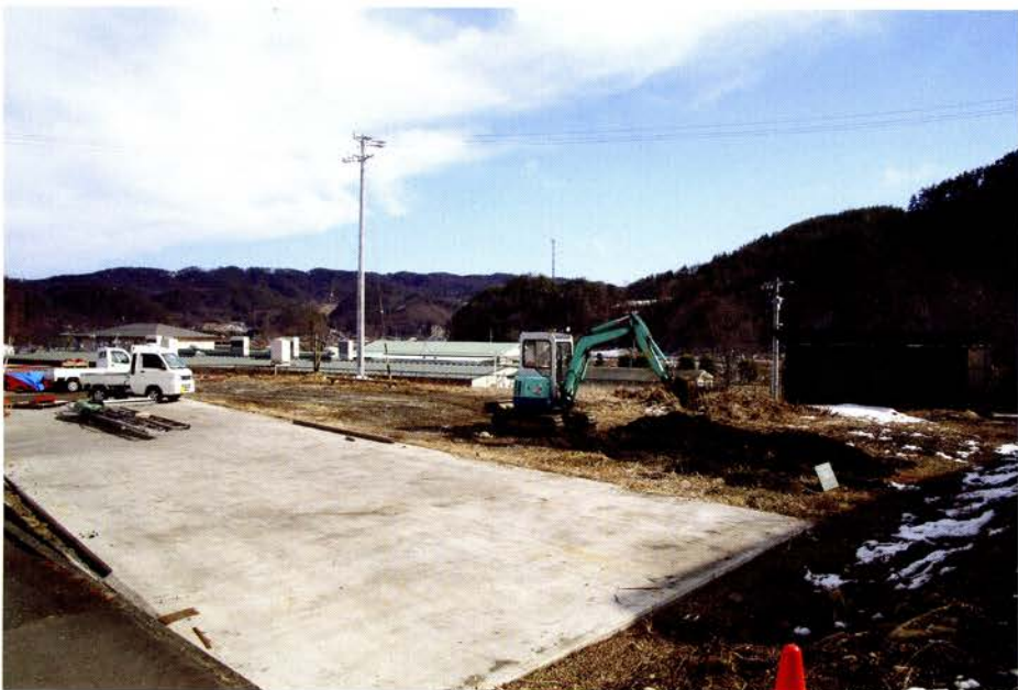
調査地（北西から）
