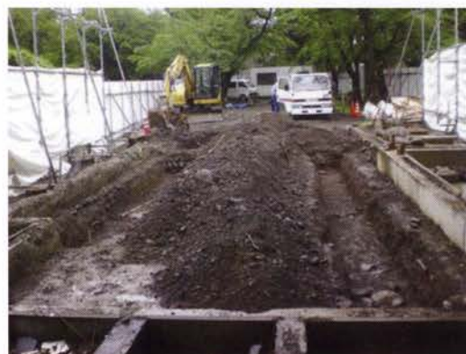
写真 27 旧社務所解体撤去時の状況
