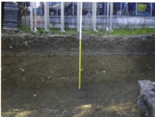
写真 52 旧伝染病院跡地北側掘削状況
