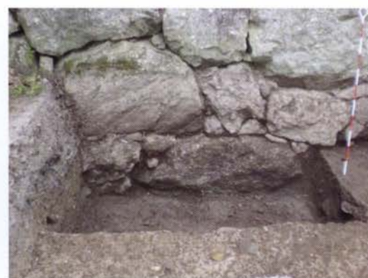
写真 4 調査区東側石垣の根石
