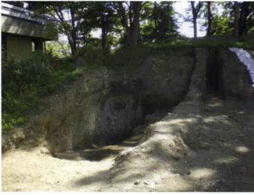
写真 75 土塁状盛土の調査完了状況
