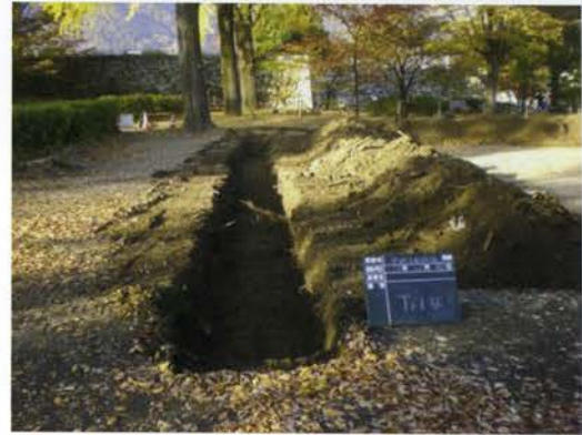
写真 47 同左トレンチ掘削状況
