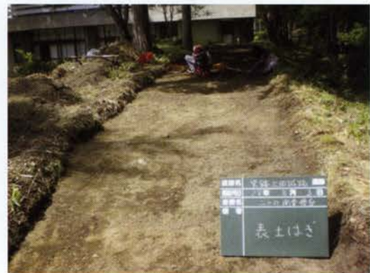
写真 64 土塁状盛土天端の調査状況
