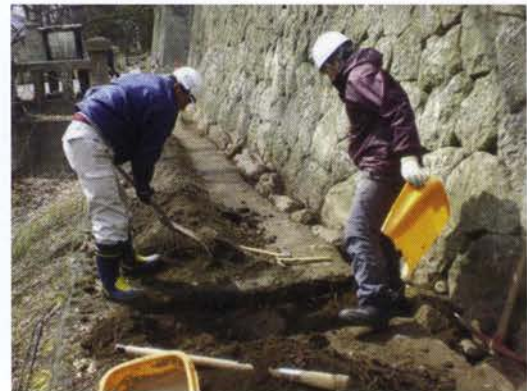
写真 17 トレンチ掘削状況
