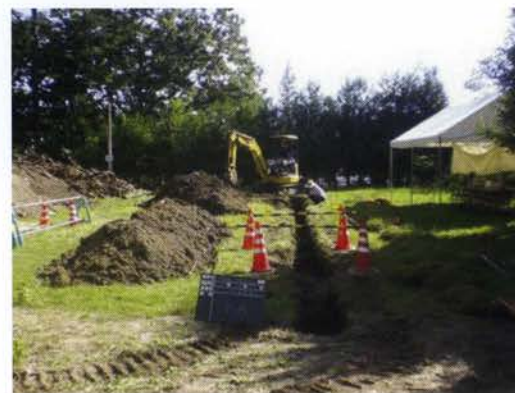
写真 72 土塁跡地のトレンチ調査
