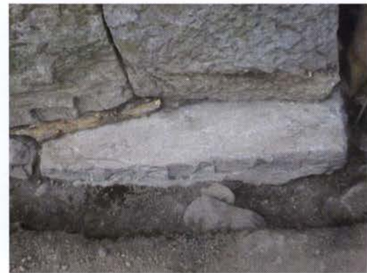
写真 21 石垣根石（北側隅）の検出状況
