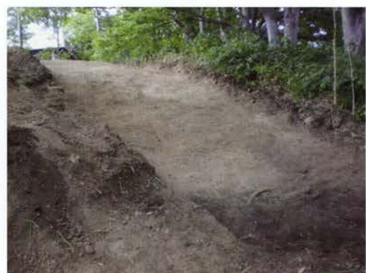
写真 66 櫓台状盛土のトレンチ掘削状況
