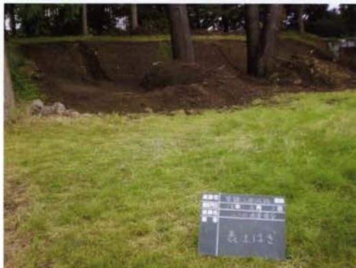
写真 63 土塁状盛土の法面の調査状況
