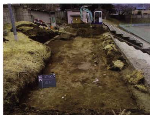
写真 90 調査完了状況
