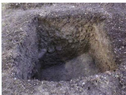
写真 57 調査区 (3) 二の丸堀の堀形検出状況
