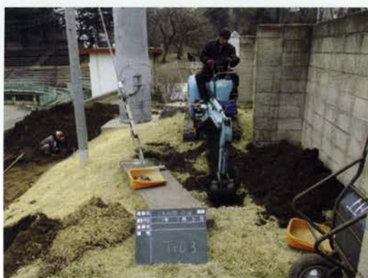
写真 83 土塁状盛土トレンチ掘削状況
