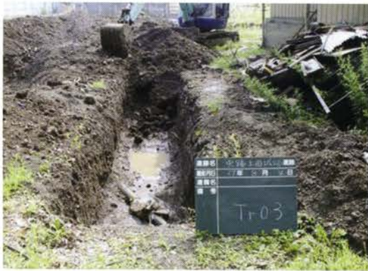
写真 48 プール跡地トレンチ掘削状況
