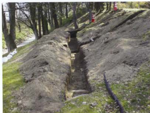
写真 35 トレンチ完掘状況
