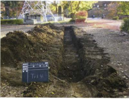
写真 46 旧伝染病院跡地トレンチ掘削状況
