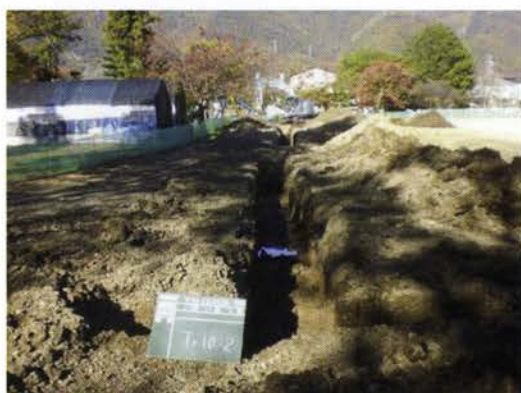
写真 44 調査区 (2) トレンチ掘削状況
