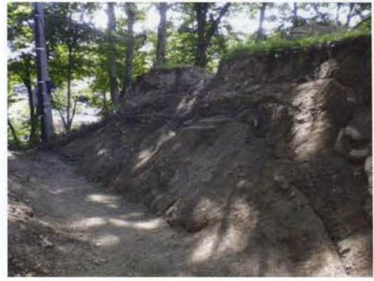
写真 76 土塁状盛土の断面調査完了状況
