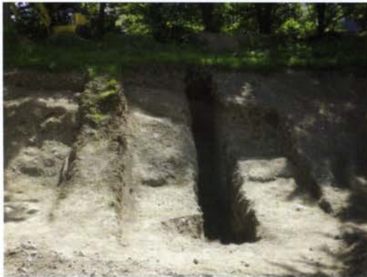
写真 77 土塁状盛土の調査完了状況
