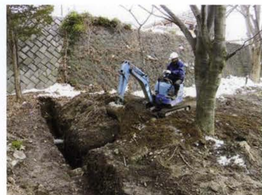
写真 82 トレンチ掘削状況
