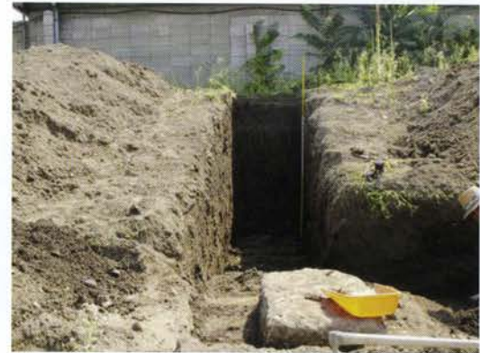
写真 49 プール南側盛土トレンチ掘削状況
