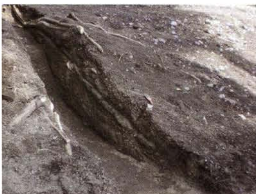
写真 65 法面トレンチ掘削状況
