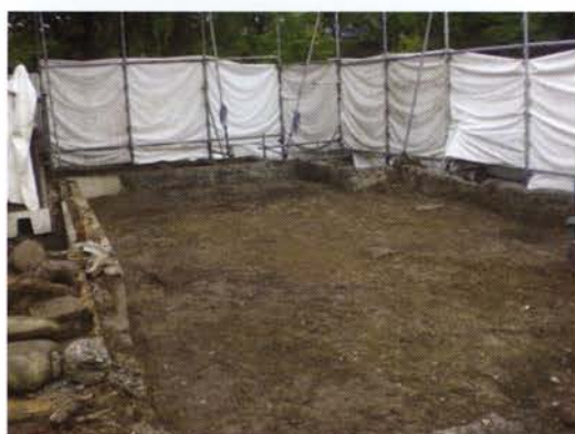
写真 28 旧社務所下の地表面
