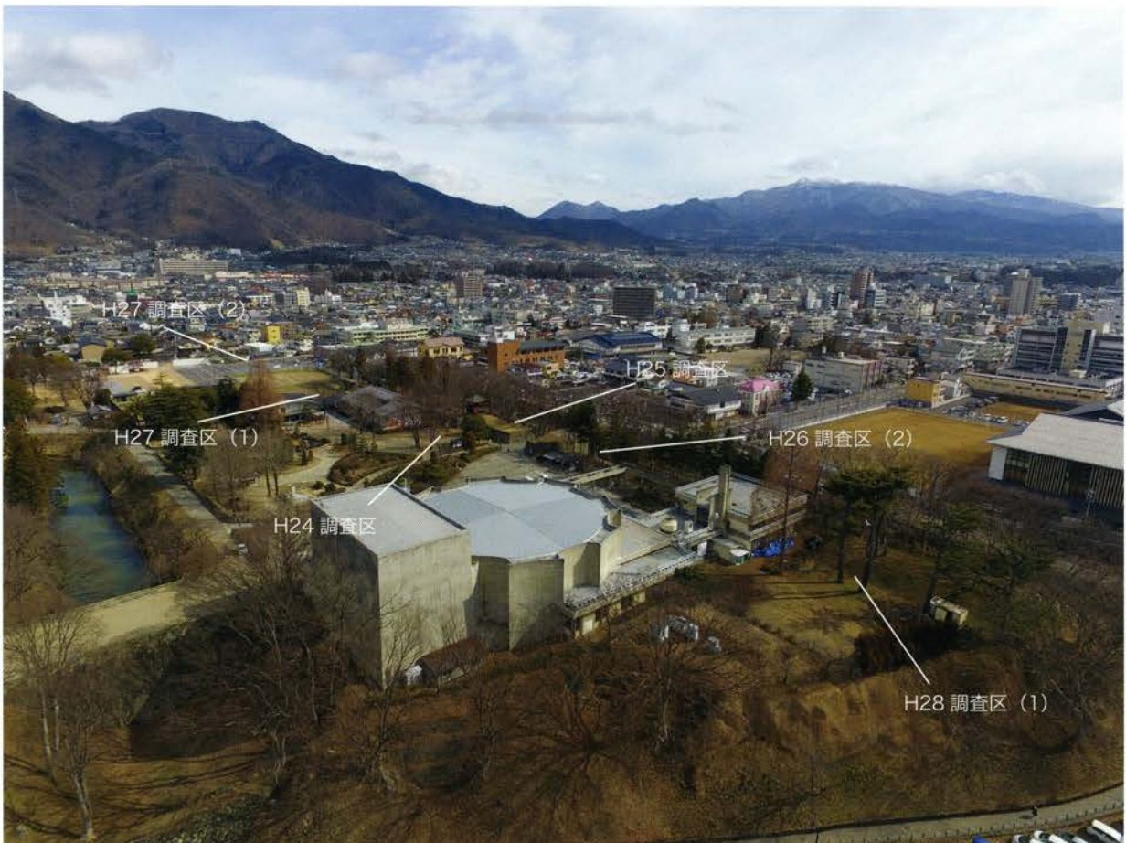
第 51 図 史跡上田城跡発掘調査実施範囲（南西上空から武者溜り・樹木屋敷方面を撮影）
