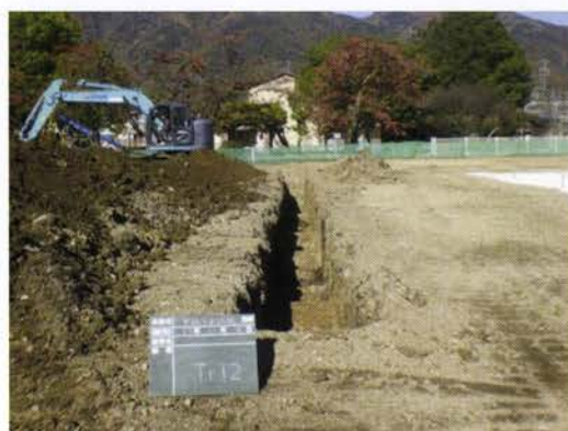
写真 45 調査区 (2) トレンチ掘削状況
