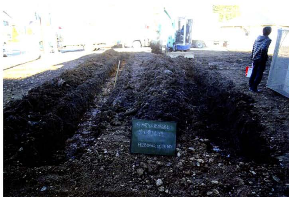
Tr-02 掘削（南から）
