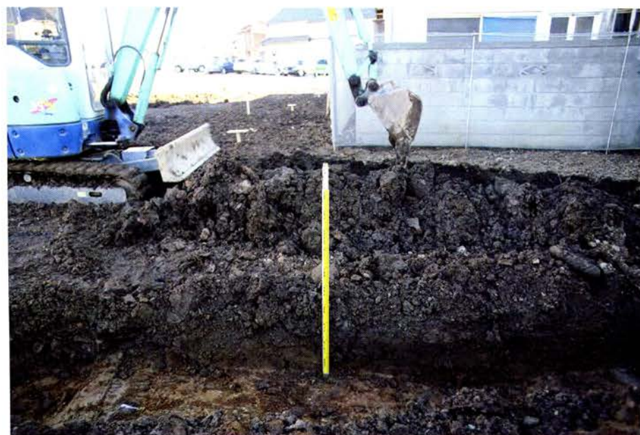
トレンチ土層（西から）
