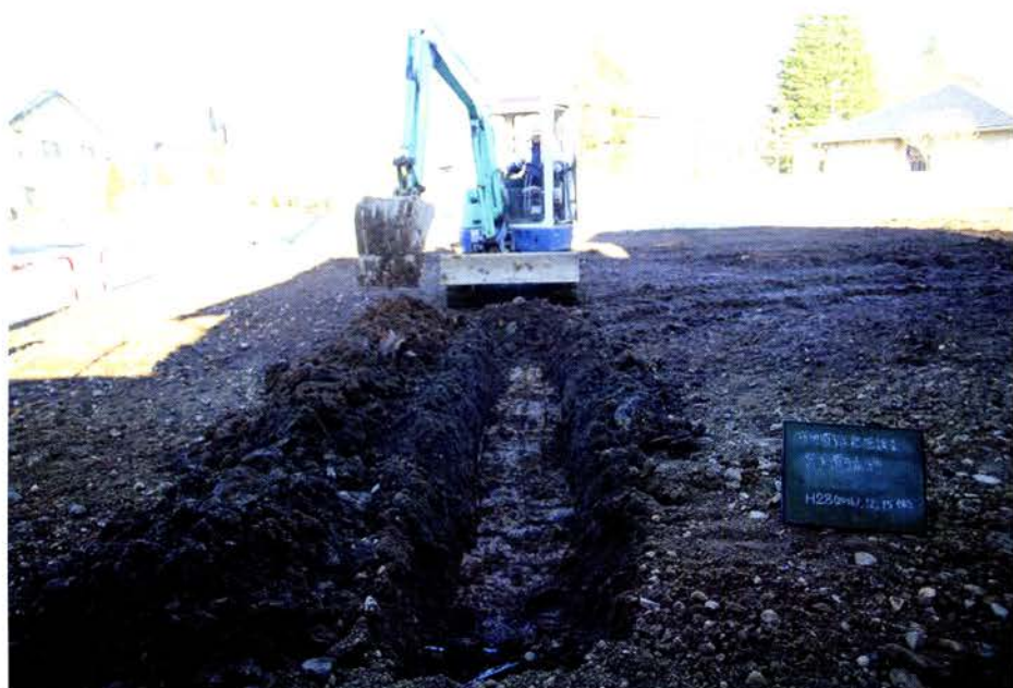
Tr-01 掘削（南から）
