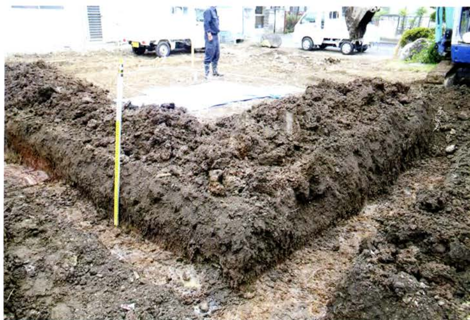
Tr-01,02 トレンチ掘削状況 (北西から)
