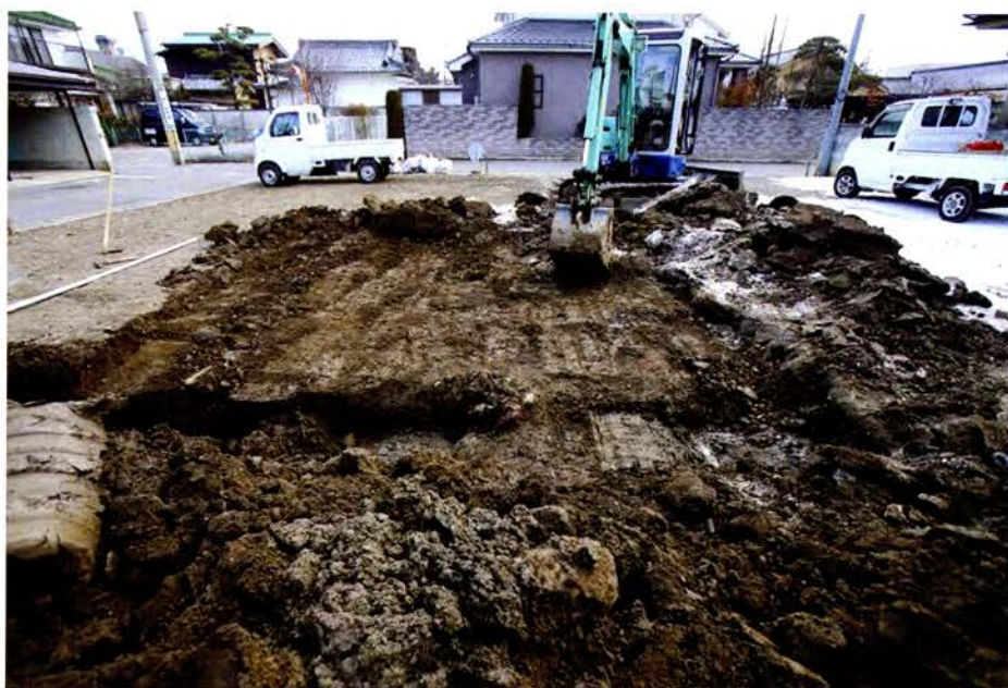
トレンチ拡幅（西から）
