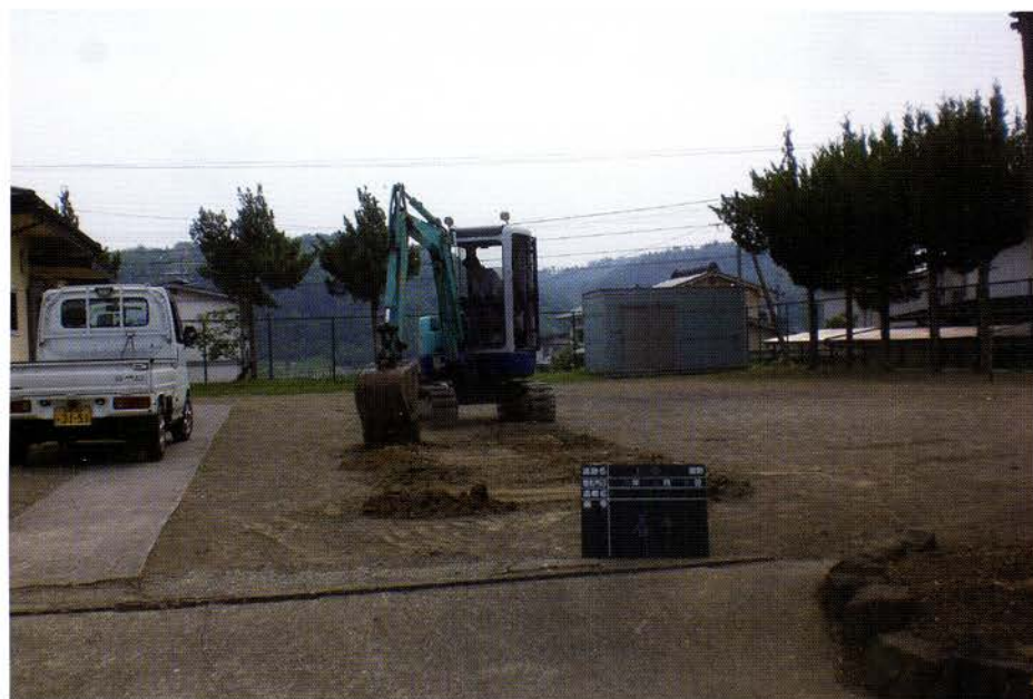
トレンチ掘削（西から）
