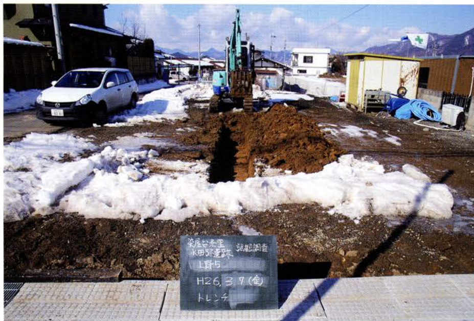
トレンチ掘削状況（南から）
