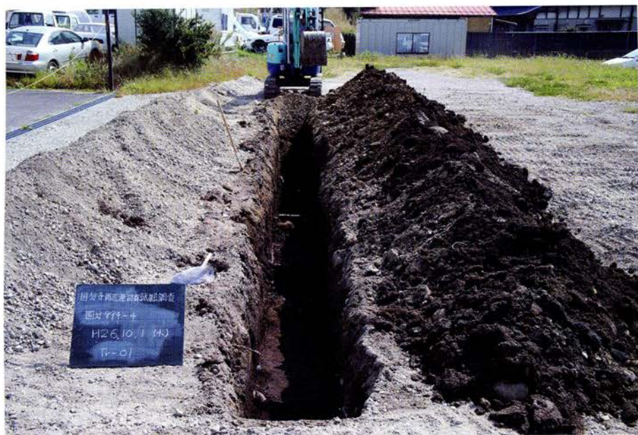
トレンチ掘削（西から）
