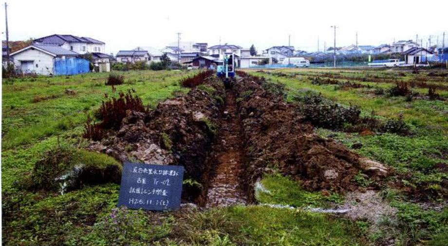
Tr-02 掘削（西から）
