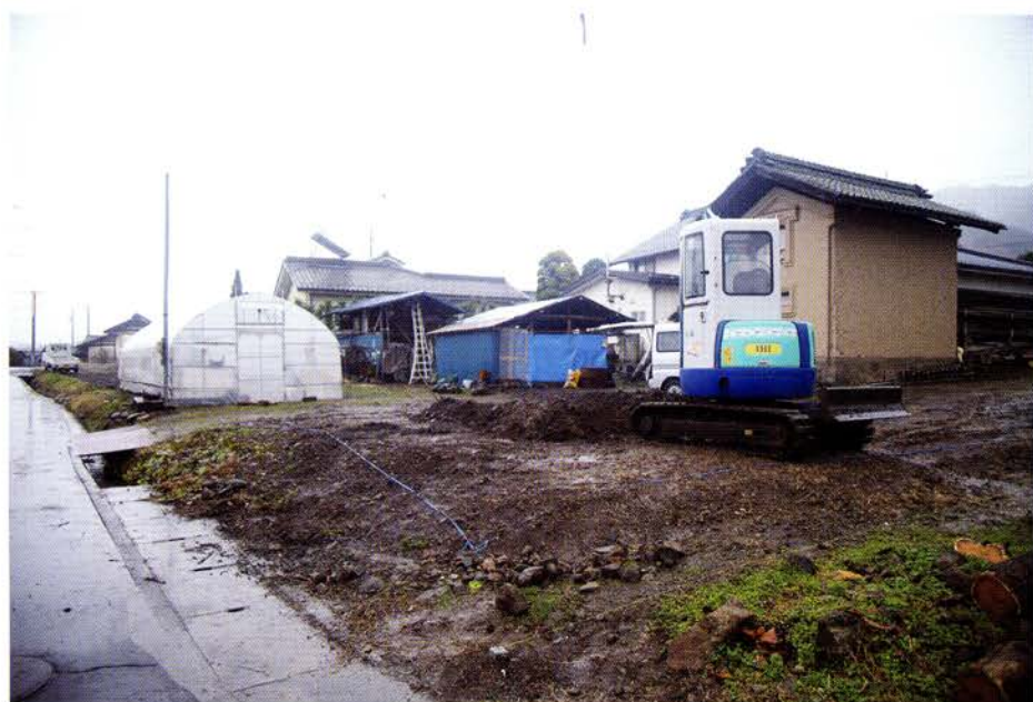
トレンチ掘削（北西から）
