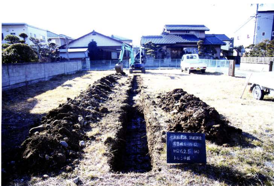
トレンチ掘削状況（北から）
