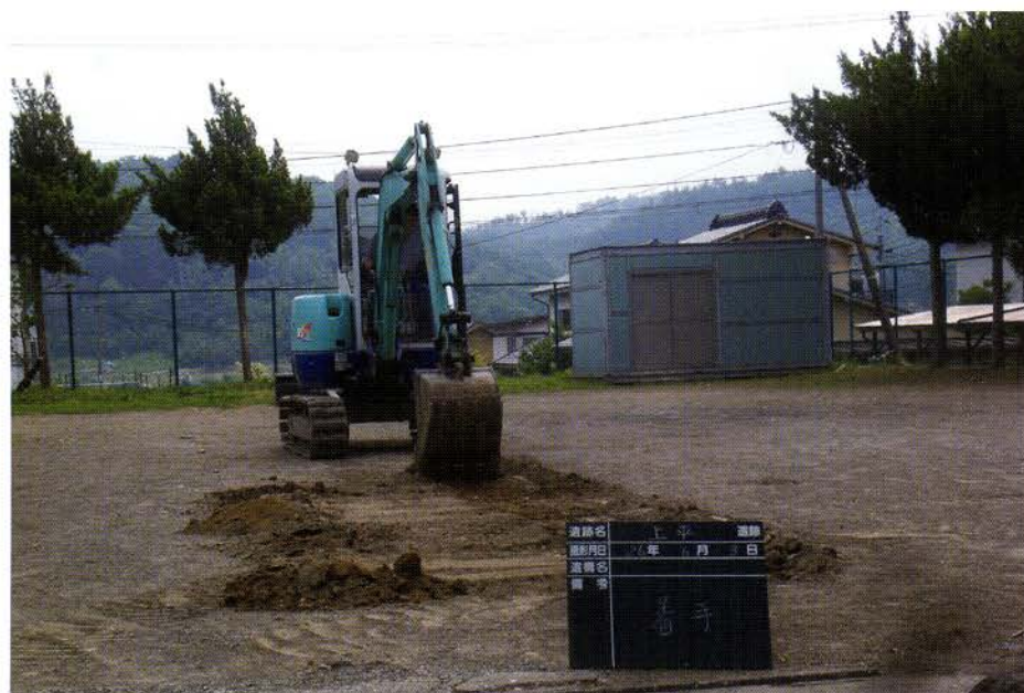
トレンチ掘削（西から）
