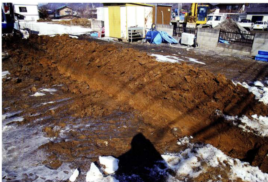
トレンチ掘削状況（南東から）
