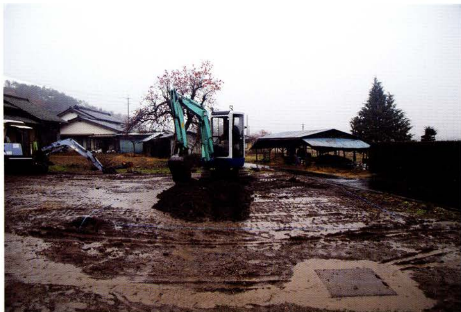
トレンチ掘削（東から）
