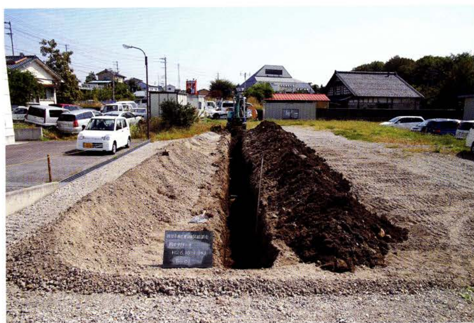
トレンチ掘削（西から）
