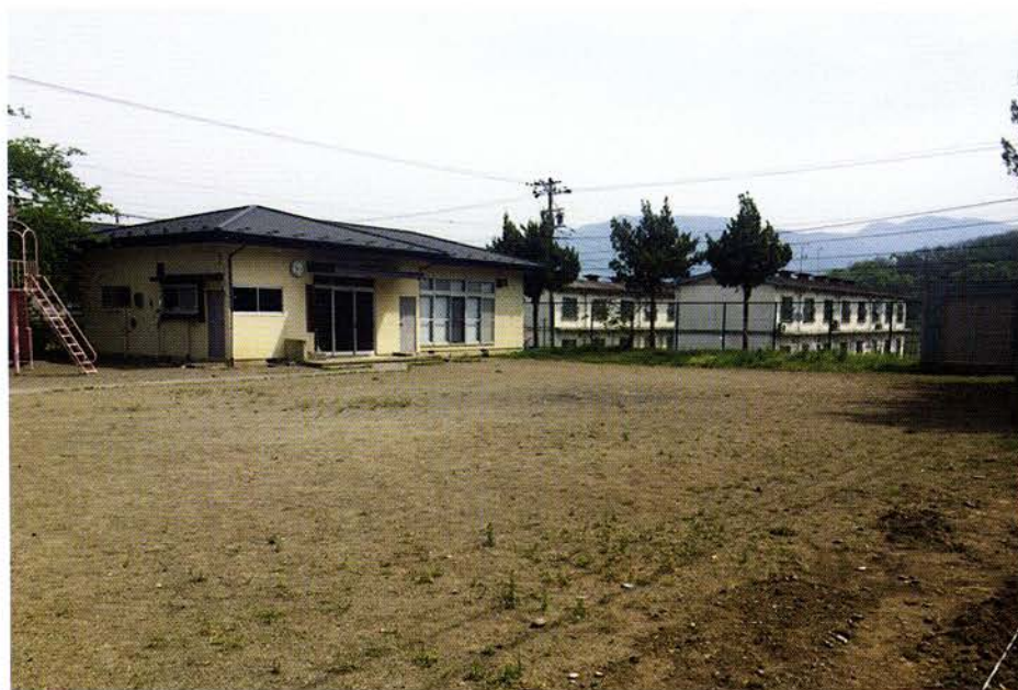
調査着手前（東から）
