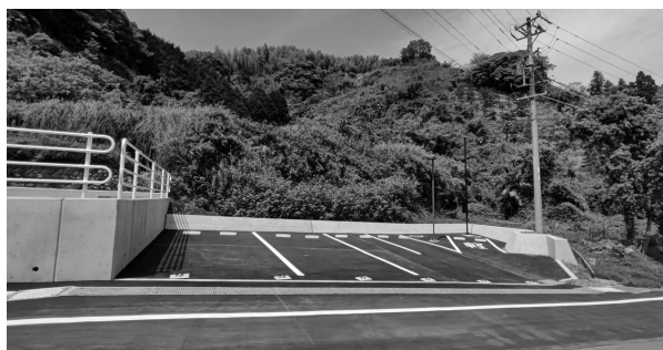
駐車場（下段）整備状況
