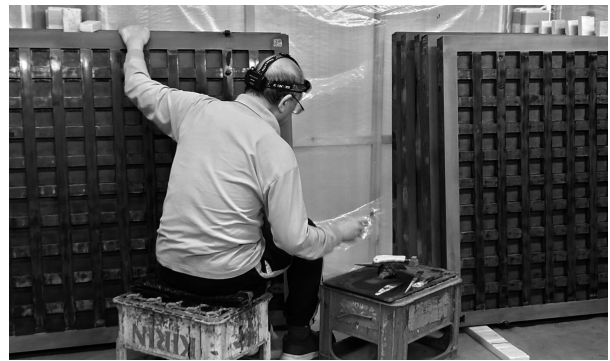
静岡浅間神社 修理現場
