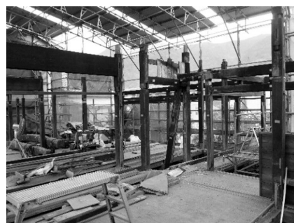
解体調査実施状況
