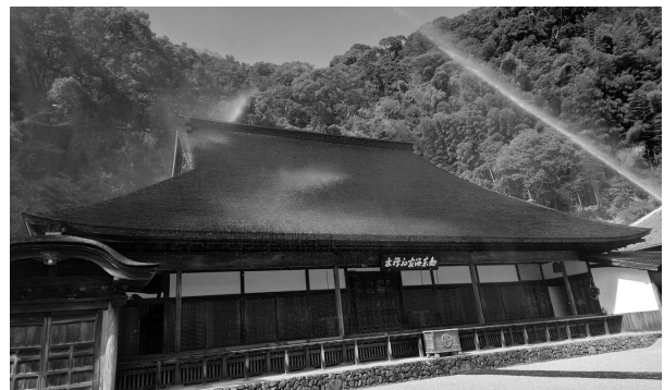
放水銃作動時
