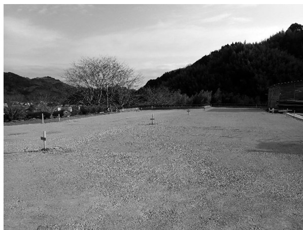
主郭盛土造成状況
