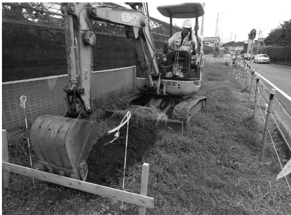
写真1 重機による表土掘削作業状況
