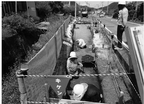
写真2 人力による掘削作業状況
