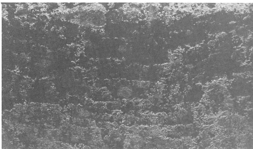
3 壁面に残された ノミの痕
