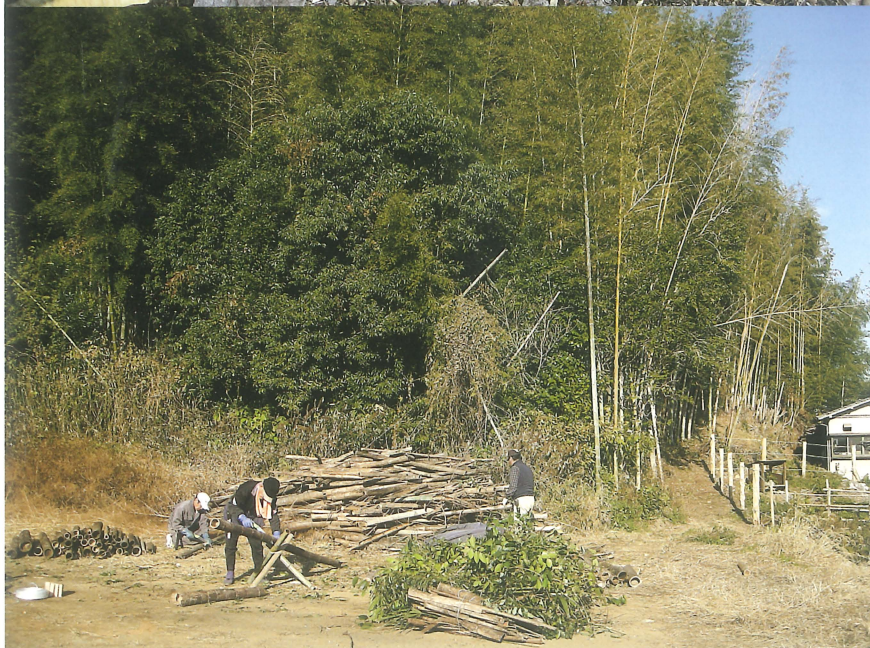
(3) 竹林伐採状況 (南より)
