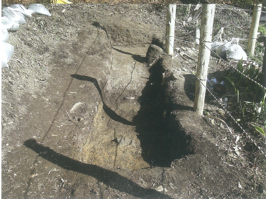
(3) トレンチ一段掘下時状況 （南より）
