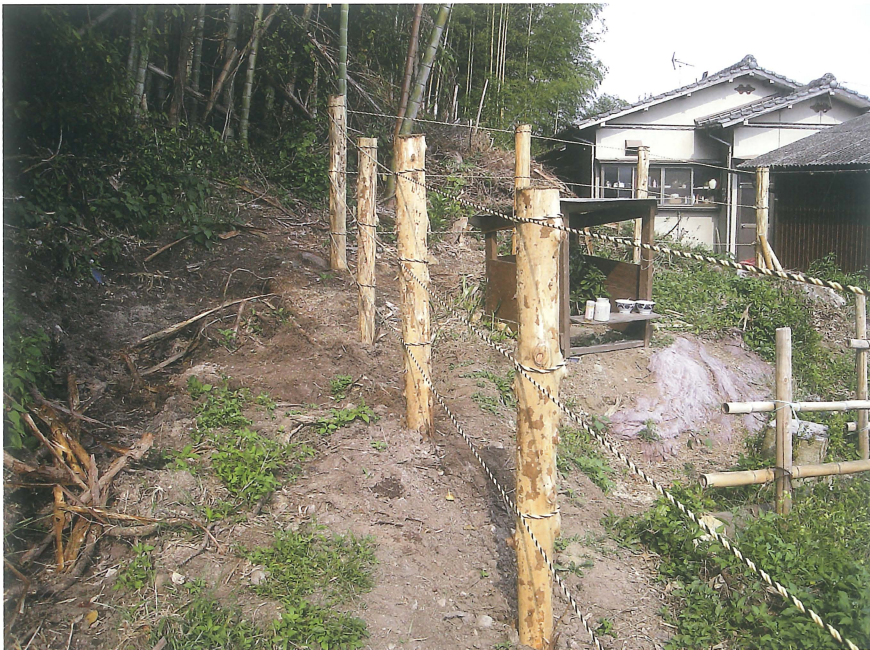
(1) 調査前風景 (南より)
