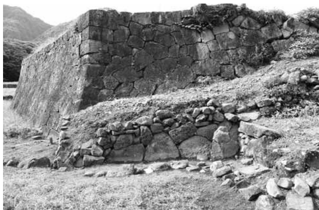
2. 主郭石垣張出し部分（南から）
