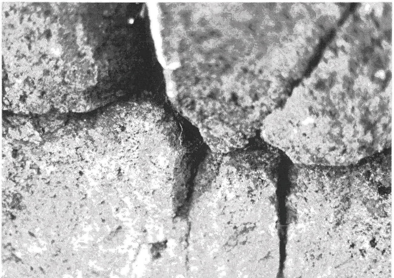
4区1号墳玄室壁石No.10とNo.11とNo.16（切組） 36
