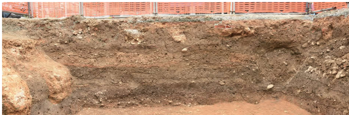
2 III区 東壁断面（西から）
