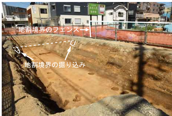
Fig.14 Ⅱ a 区地割境の状況
