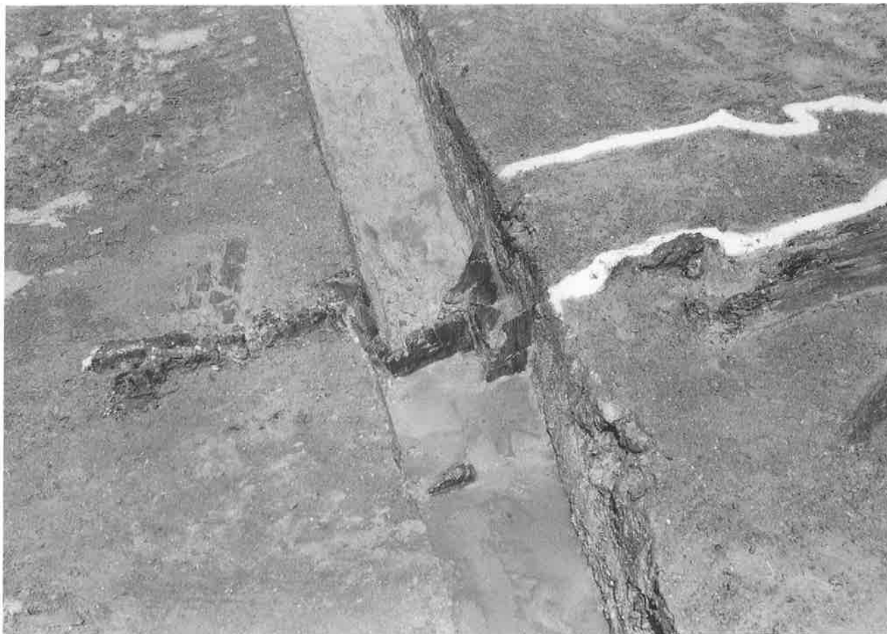
a 杭・矢板による畦補強状況
