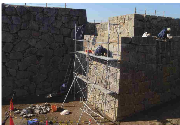
天端面施工状況
