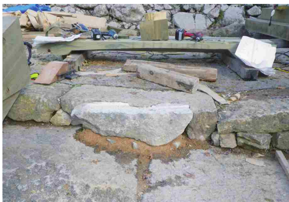
木製階段最上部石加工
