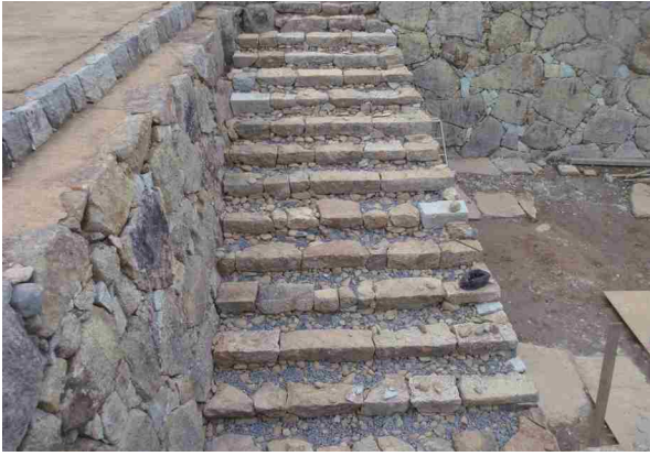
石段積み直し（舗装前）
