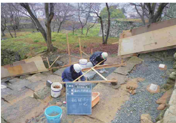
階段の束石据え付け
