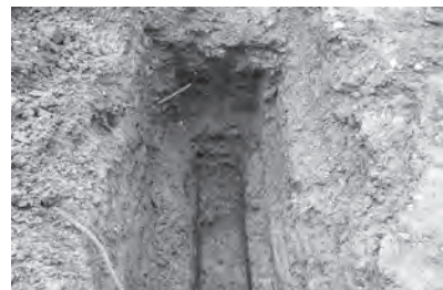
第78図 トレンチ掘削状況
