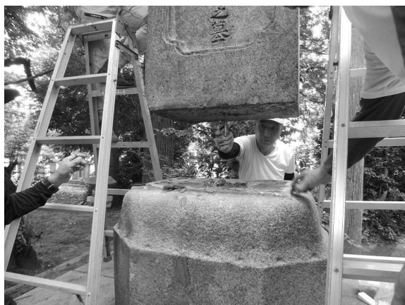
④-3 墓標と基礎の間にステンレス棒挿入
