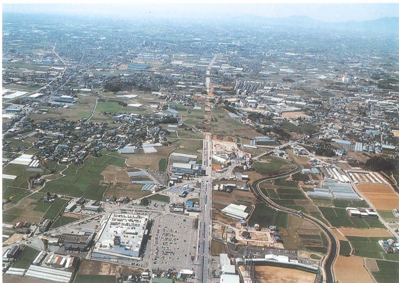
(2)一般国道442号八女筑後バイパス調査地航空写真(八女市蒲原上空東から)〔H.17年撮影〕
