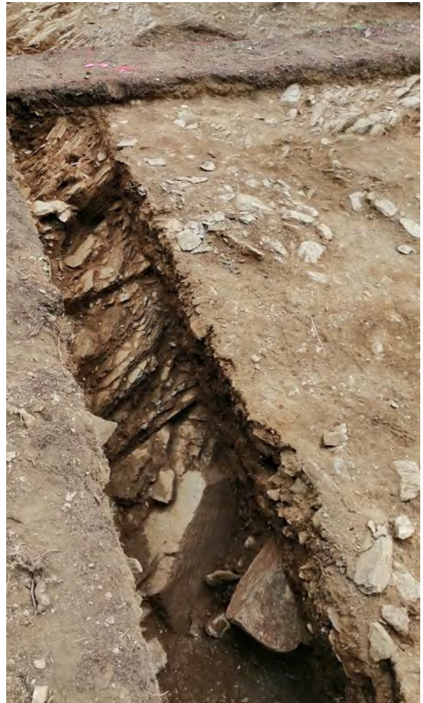
上段郭西端岩盤掘削 (中央) 造成土 (右) (4TsbT 西北より)
