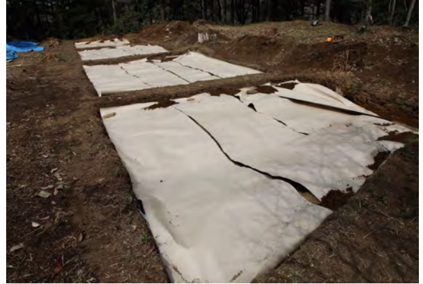
養生シート被覆
