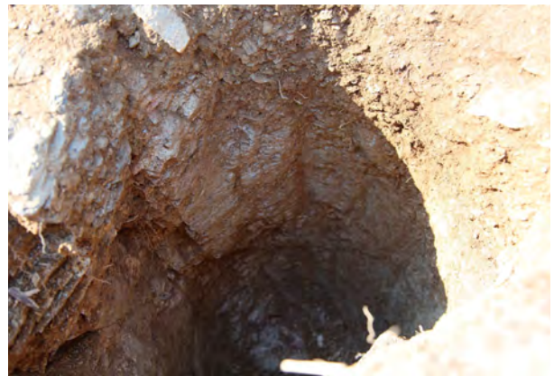
2 P 岩盤掘削痕
