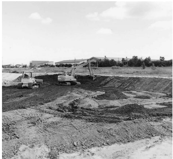
重機による法面施行状況 N→S
