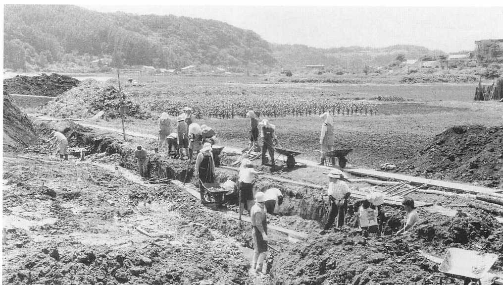
排水溝掘開作業
