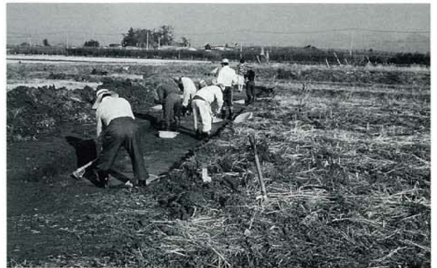
トレンチ面整理作業状況 (南から)
