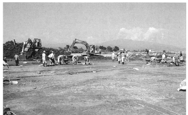
A区作業状況（東から）
