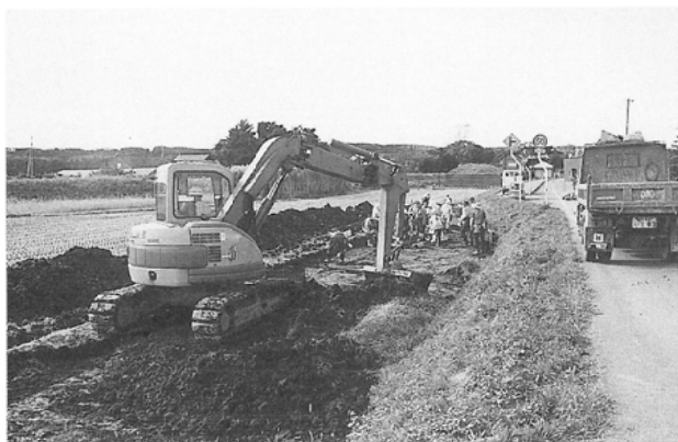
重機械表土除去
