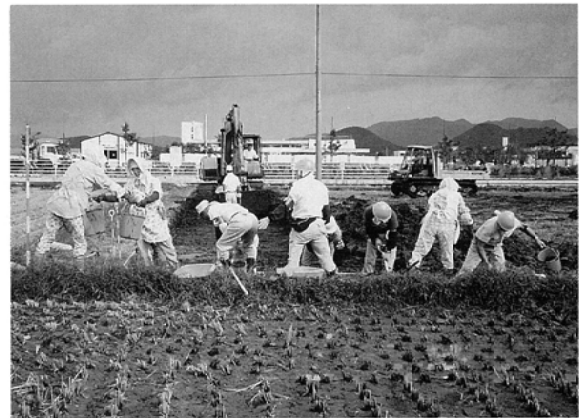
重機粗掘・排水風景（南から）
