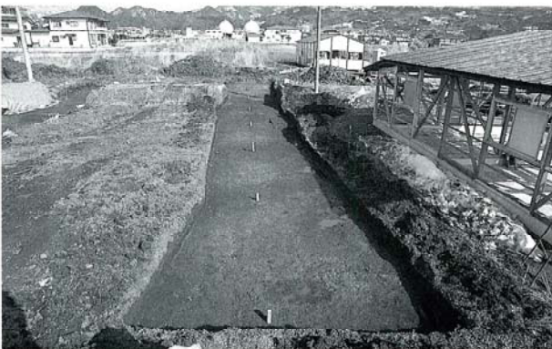
D区遺構検出状況（西から）
