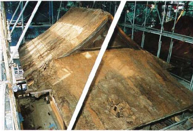
3-8 b 土居葺破損状況
