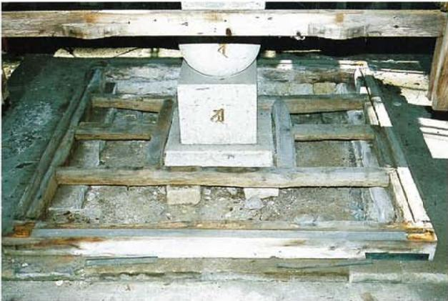
3-6 d 揚屋完了・床組破損状況
