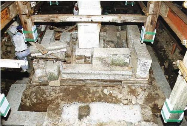
3-6 f 雨落石基礎コンクリート打設状況
