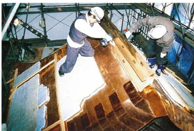
3-9 b 箱棟銅板包施工状況
