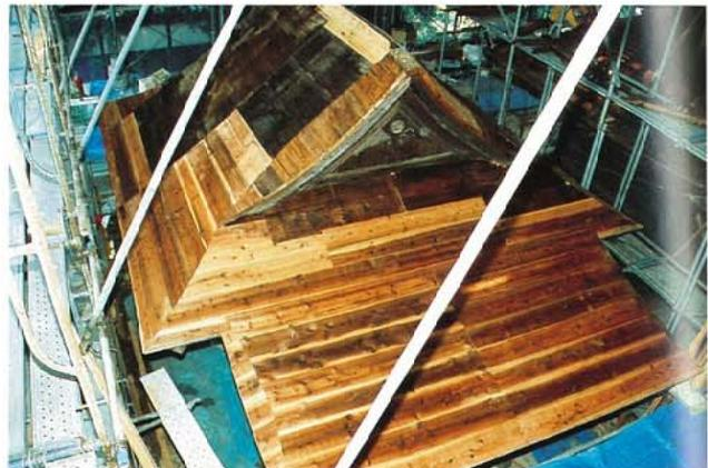
3-8 e 野地板補修完了
