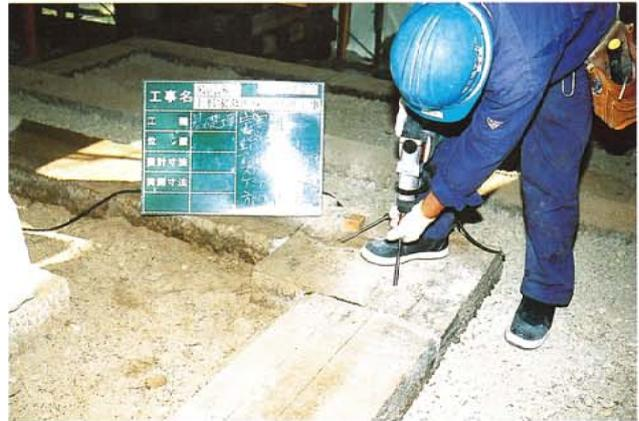
3-7 e 基礎アンカーボルト取付状況
