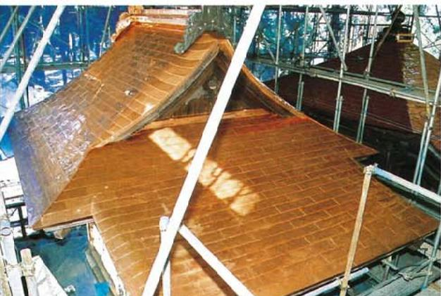
3-8 h 屋根銅板葺施工完了
