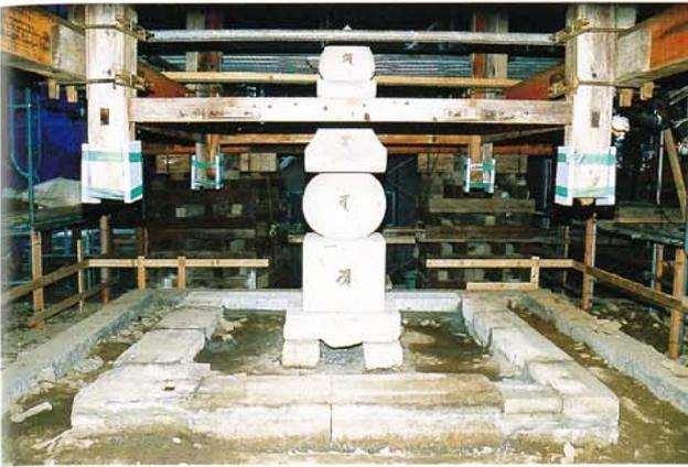
3-7 b 基礎石・五輪塔据直し完了
