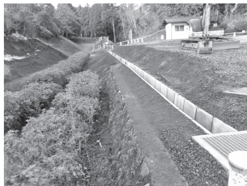
排水溝新設整備（三ノ丸西堀）
