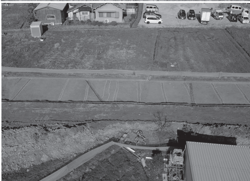
3. 6区 1069～1071・1073・ 1074・1076～1080 溝 全景 (南東から)
