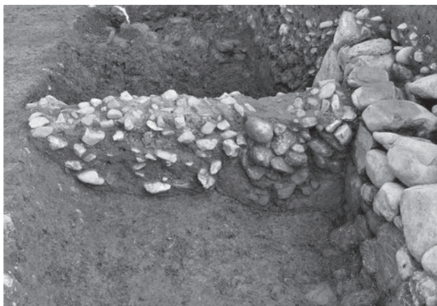
1. 4区 713 石積み基礎 Aライン断面 (南西から)
