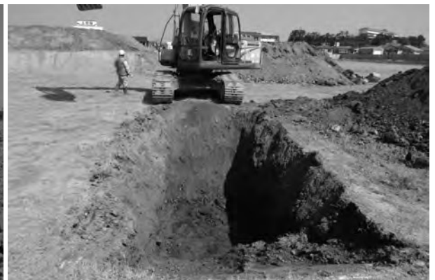
3 G 2 坑 完掘状況（南から）
