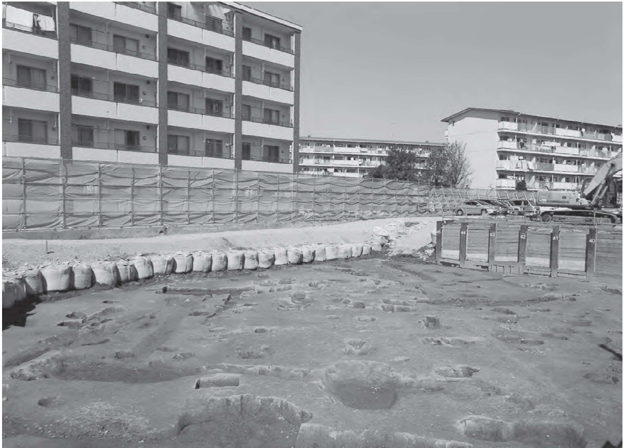
1 SD01・SD02 完掘状況（南から）
