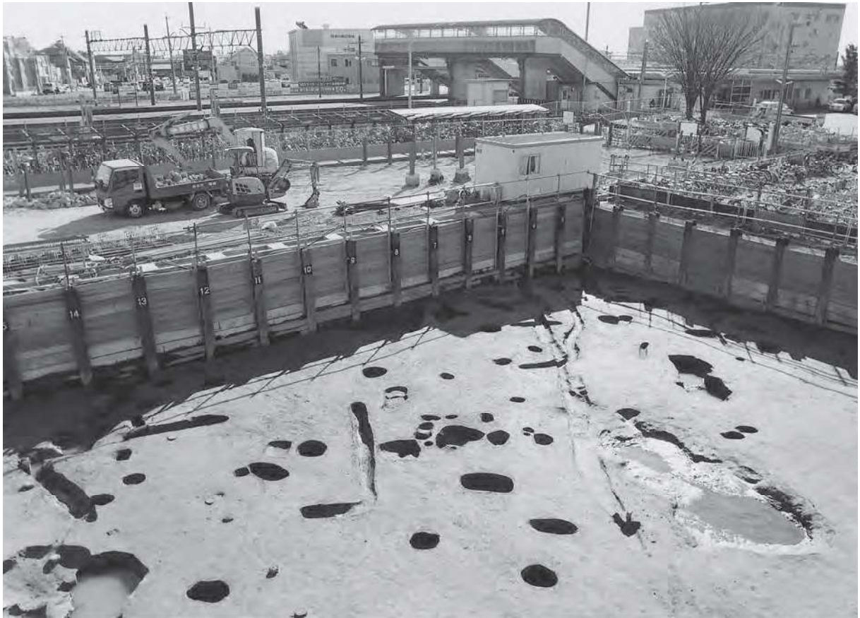
1 2工区 全景（北東から）
