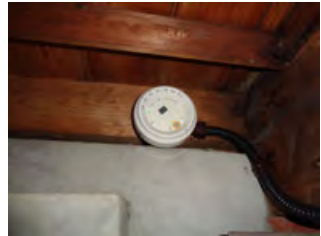
〔写真 3-88〕 自動火災報知設備無 線アンテナ (洋館地下)
