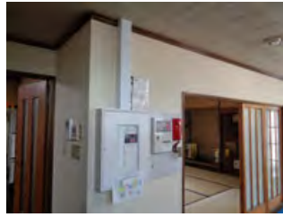
〔写真 3-86〕 自動火災報知設備 (主屋)
