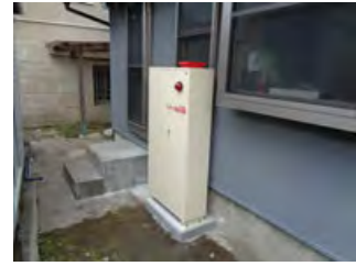
〔写真 3-87〕 パッケージ型 消火設備 (離れ西側)
