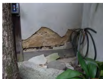
[写真 4-22] 東高塀 小壁左官亀裂
