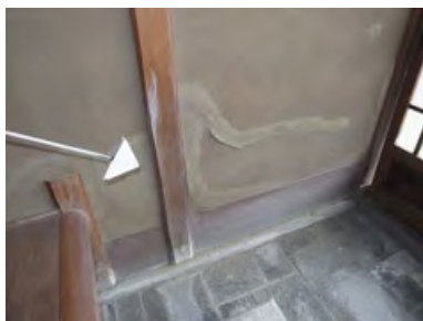
[写真 4-28] 玄関 左官壁一部毀損
