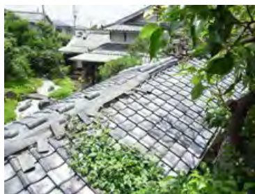
[写真 4-25] 棟瓦、平瓦、軒瓦のずれ、ツタ等の繁茂が屋根土に到達
