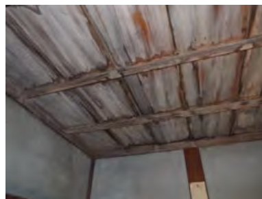
[写真 4-29] 女中部屋 天井雨漏り跡
