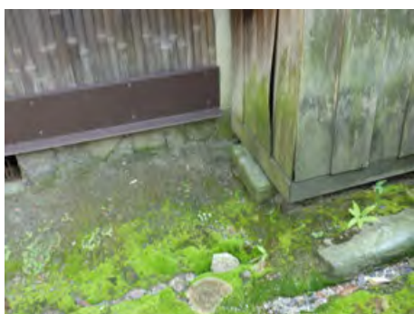
[写真 4-7] 主屋束石の欠損・移動（北東庭）
