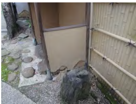
[写真 4-32] 左官袖壁腐朽
