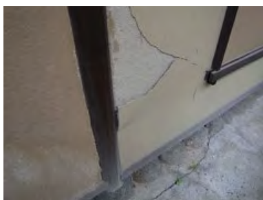
[写真 4-30] 壁面 土壁毀損
