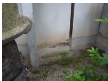
[写真 4-21] 北高塀 壁剥落
