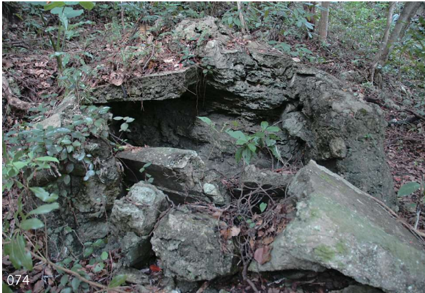
写真 4.5 H -02 号墓現況（予備調査時）
