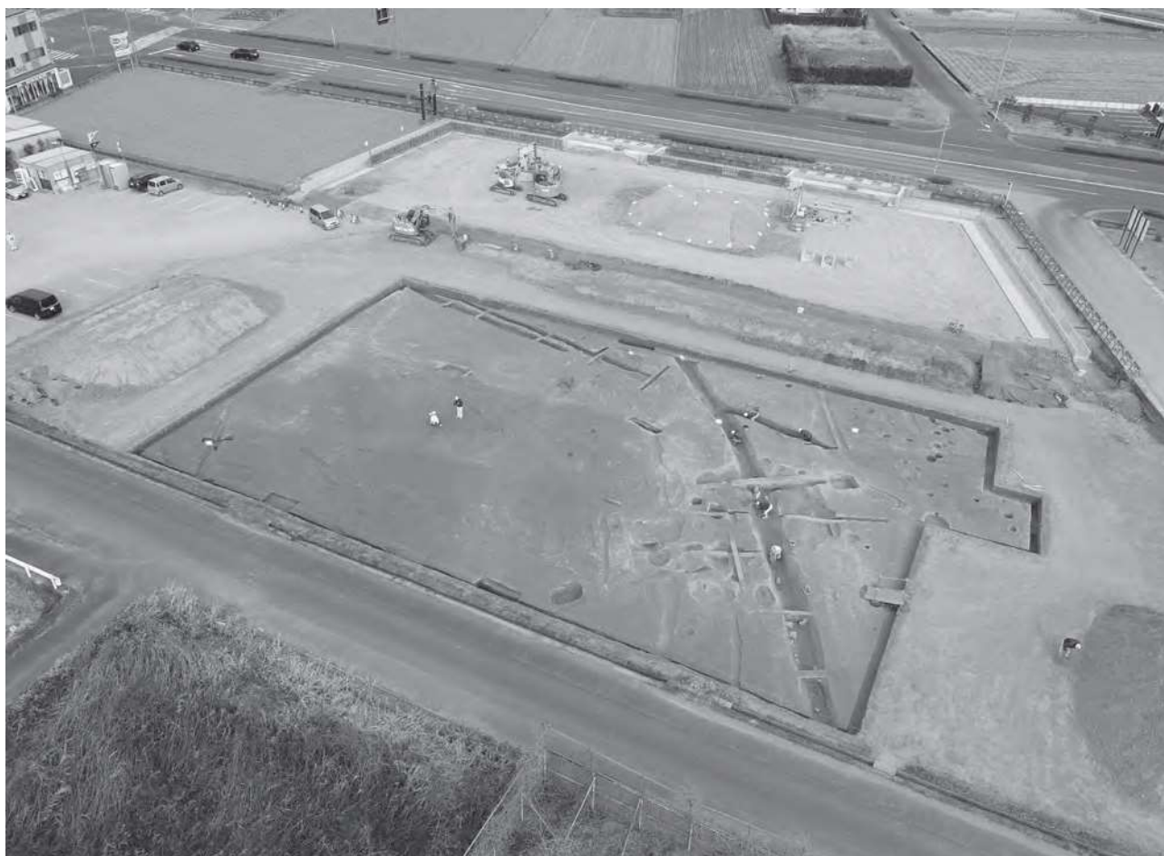
2 V区 掘削状況 南西から
