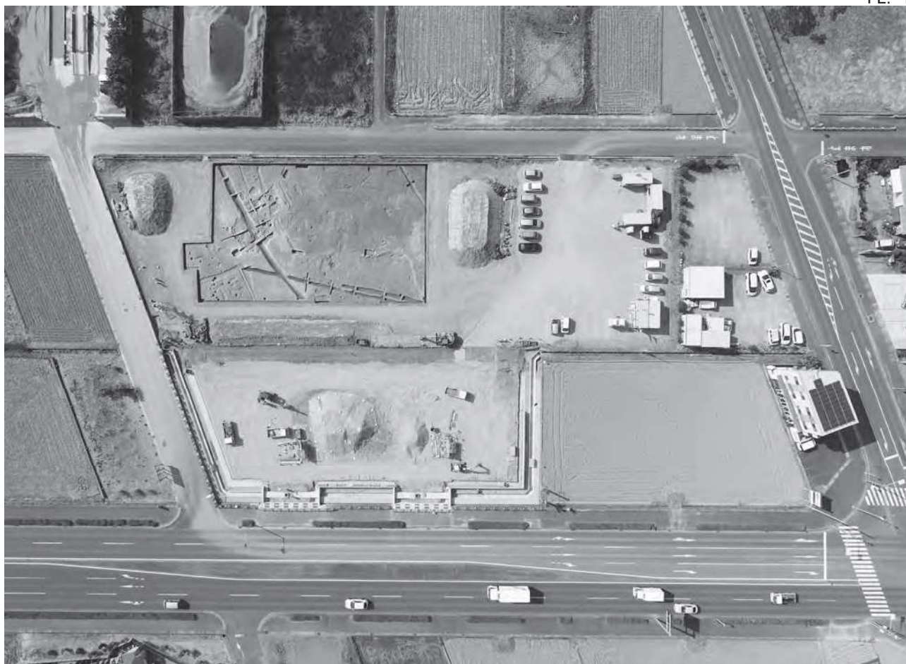
1 調査区全景 直上から
