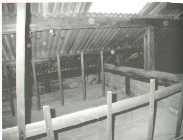
写真 6-1 製材された材による母屋 (64A)
