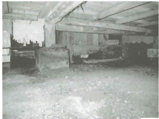
写真 6-15 642A 半端な土壁の最下部
