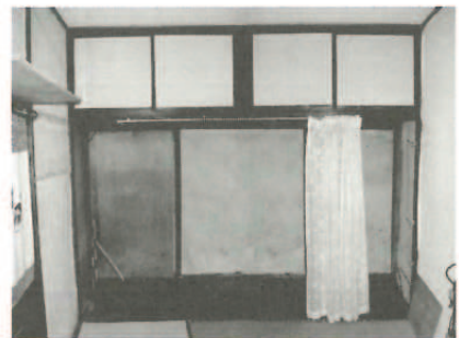
写真 4-4 1.5畳幅押入(付け柱付)
