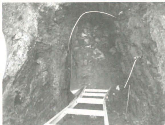
写-184 接地極埋設穴 耐火煉瓦の塊が見える。
